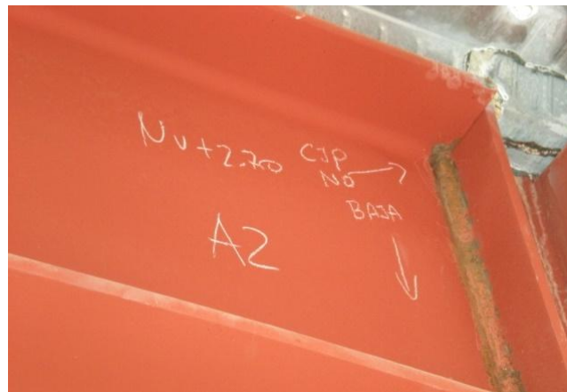
Figura 29. Junta a penetración completa no soldada
