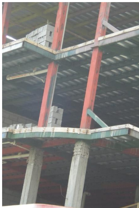
Figura 45. Transición columna de hormigón – columna metálica
