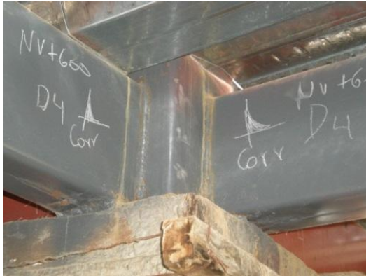
a) Soldadura en obra
