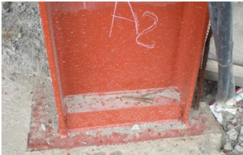
Figura 30. Unión placa base – columna tipo I
