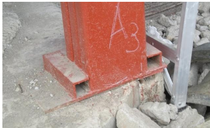
Figura 32. Unión placa base – columna tipo cajón
