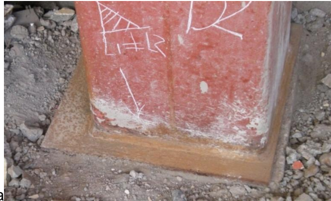
Figura 39. Unión placa base - columna
