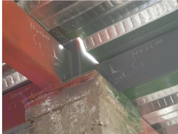
Figura 47. Conexión columna – viga principal
