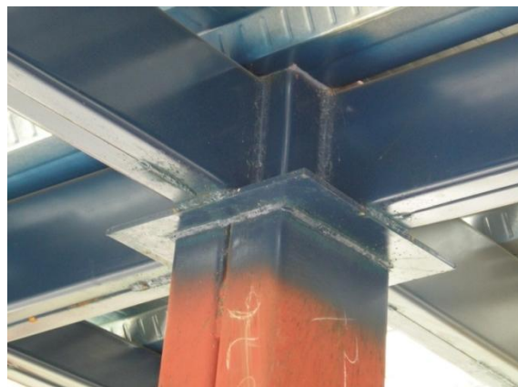
Figura 49. Transición columna – columna
