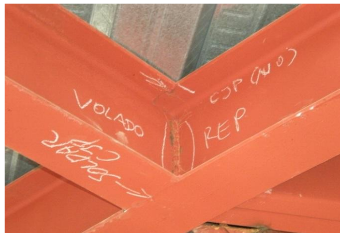
Figura 35. Conexión de Volado
