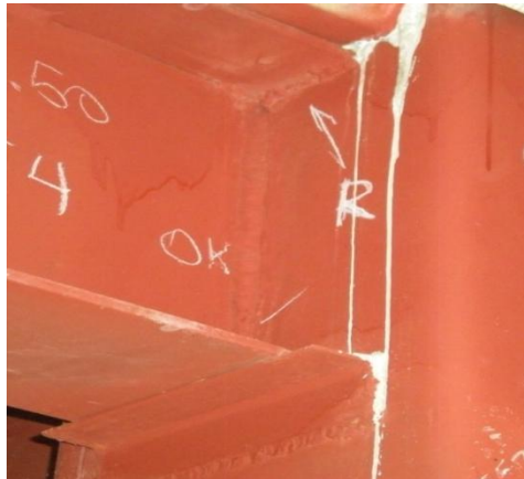
Figura 41. Conexión columna – viga principal
