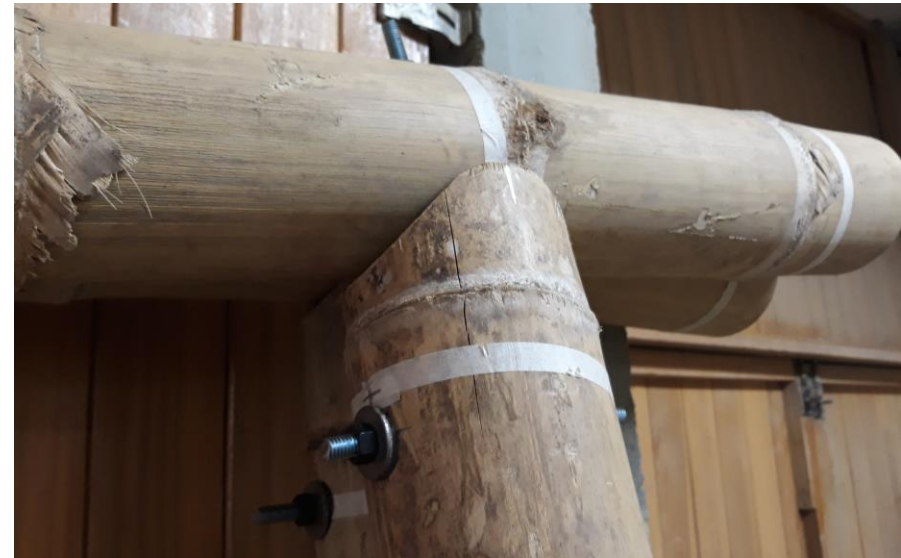
Imagen 3.44: Unión a boca de pez con perno tensor. Fuente: Cabrera, César. Archivo personal.
