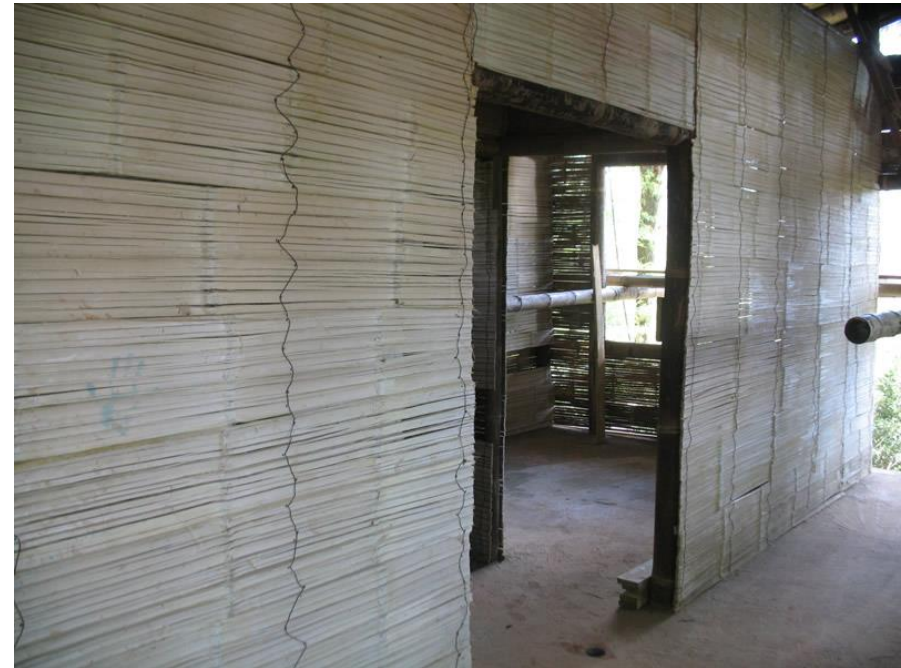
Imagen 2.13: Recubrimiento con caña picada.
