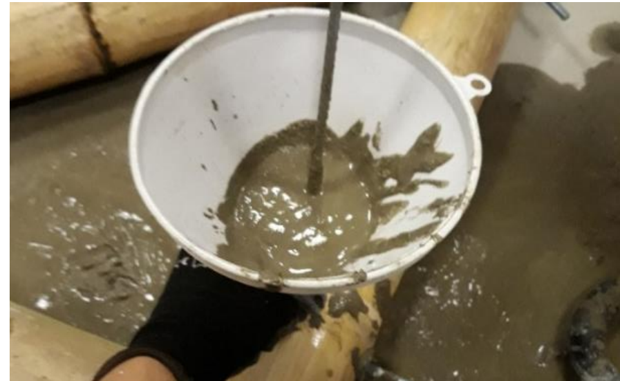
Imagen 3.21: Vertido del mortero. Fuente: Cabrera, César. Archivo personal.
