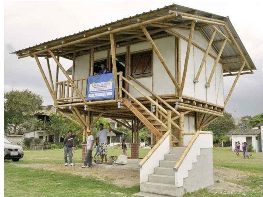
Imagen 4.8: Prototipo de casa elevada de bambú en Olón, Santa Elena.
