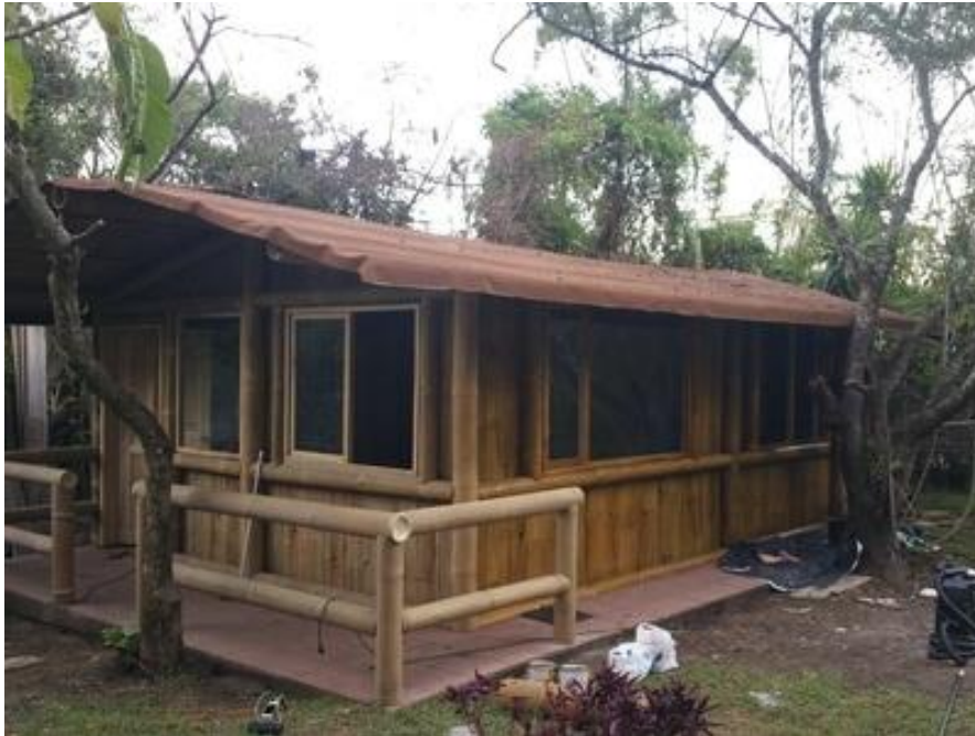
Imagen 4.5: Vivienda de bambú gigante y caña guadúa terminada. Fuente: CAEMBA. Gallery. [Imagen]. Recuperado de: http://www.caemba.com/gallery.html
