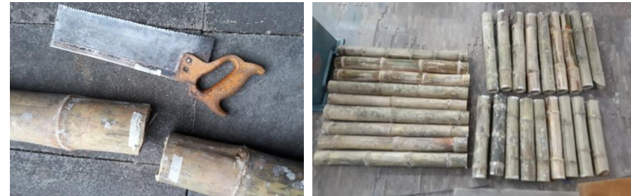
Imagen 3.14: Corte de los elementos de Caña Rolliza.
