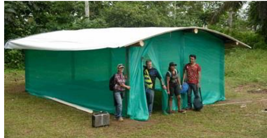
Imagen 4.1: Vivienda de bambú gigante progresiva.
