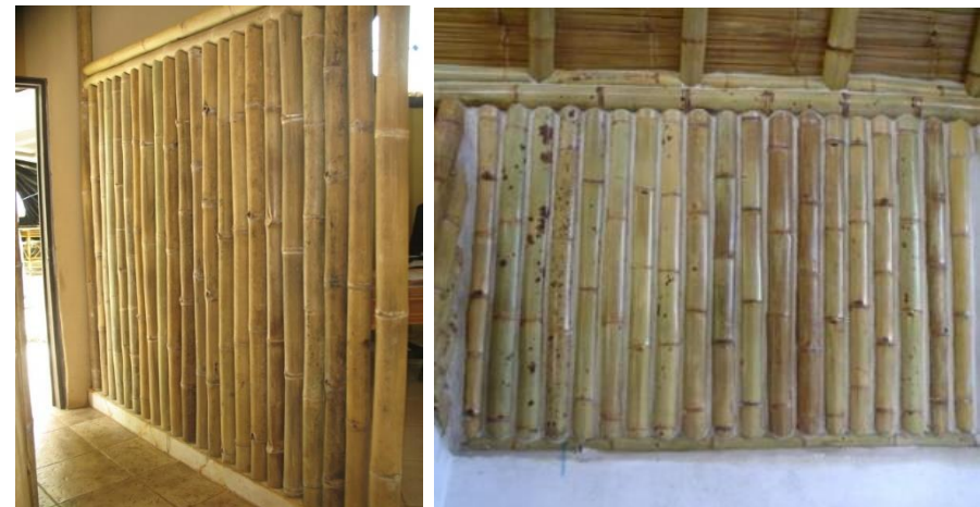
Imagen 2.5: Paneles con rollizos de caña.
