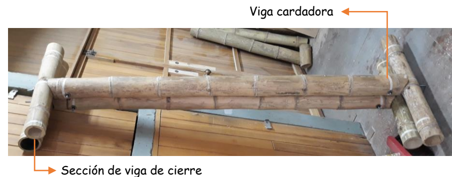
Imagen 3.44: Unión a boca de pez con perno tensor. Fuente: Cabrera, César. Archivo personal.
