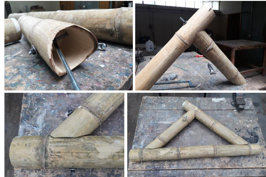
Imagen 3.17: Armado de la Estructura. Fuente: Cabrera, César. Archivo personal.
