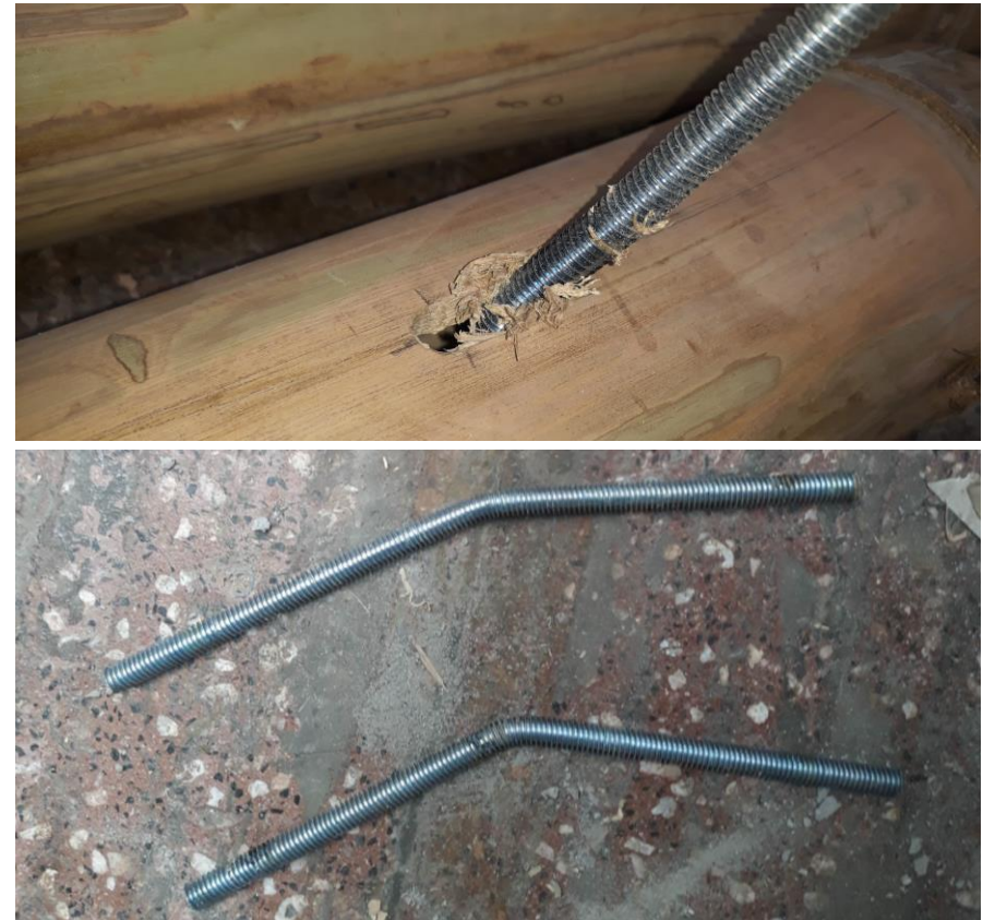
Imagen 3.30: Desplazamiento de la junta inferior. Fuente: Cabrera, César. Archivo personal.
