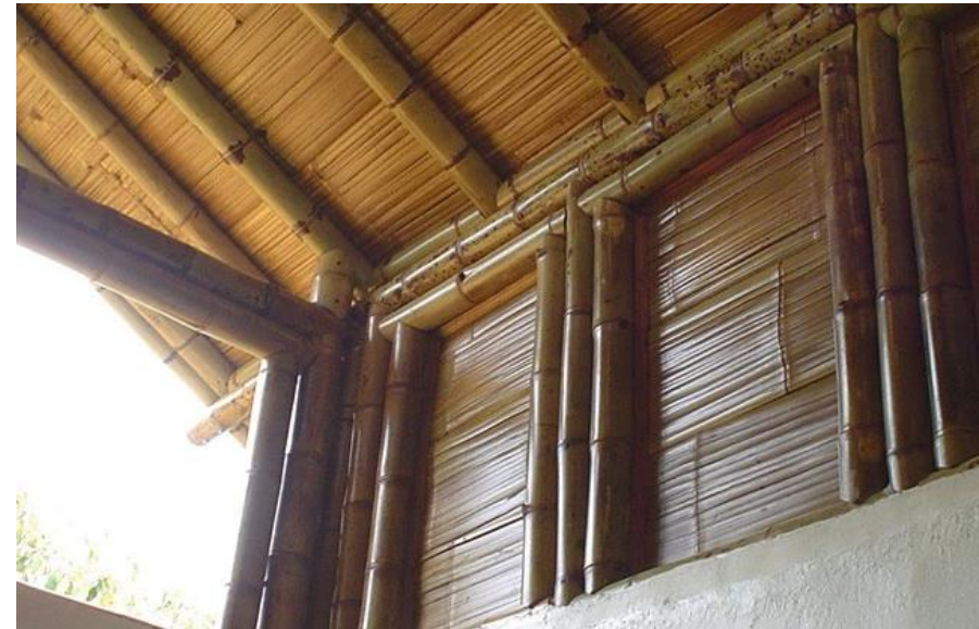
Imagen 2.6: Paneles con estructura de pie derecho y solera con recubrimiento. Fuente: BambuTico SA. Pisos y paredes de bambú [Imagen]. Recuperado de http://www.bamboocostarica.com/mod_galeria/Fotos-Categoria68.html#text
