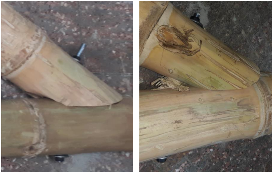
Imagen 3.29: Aplastamiento entre los cordones superior e inferior. Fuente: Cabrera, César. Archivo personal.
