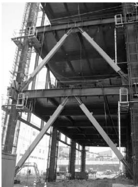
Ilustración 3. Edificio con riostras de pandeo restringido. Cortesía del profesor Mamoru Iwata, Universidad de Kanagawa, Japón.
