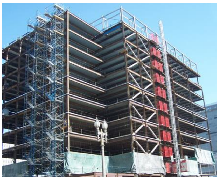
Ilustración 4. Edificio de administración del Departamento de Policía de Los Ángeles, Estados Unidos. Cortesía de Kurt Fischer Ingeniería Estructural.
