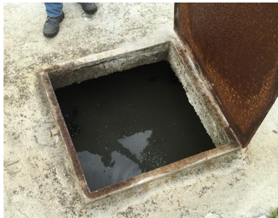
Gráfico 5.13. Agua Residual en el primer compartimiento del tanque séptico.
