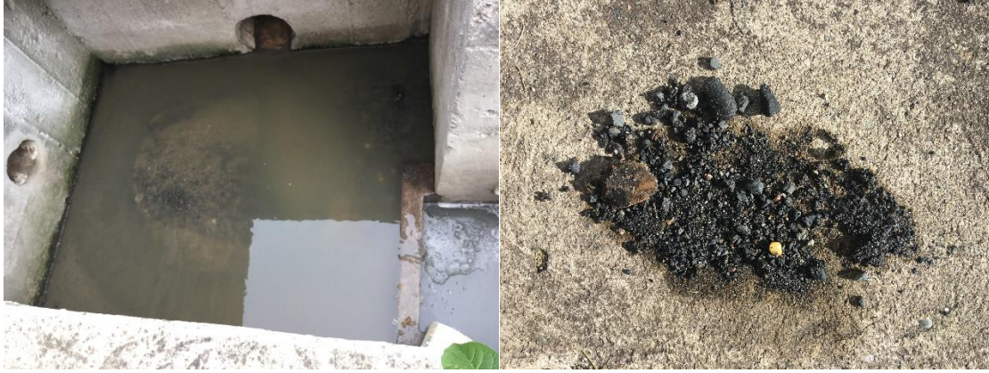
Gráfico 5.10. Retención de arenas y materia orgánica en el cajón de llegada.
