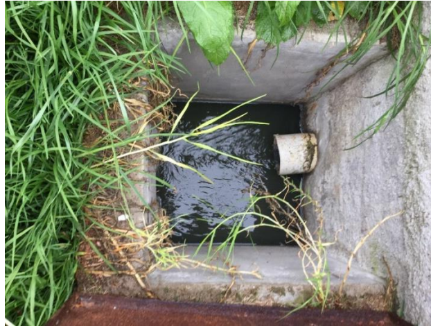
Gráfico 5.16. Estructura de efluente de los humedales.
