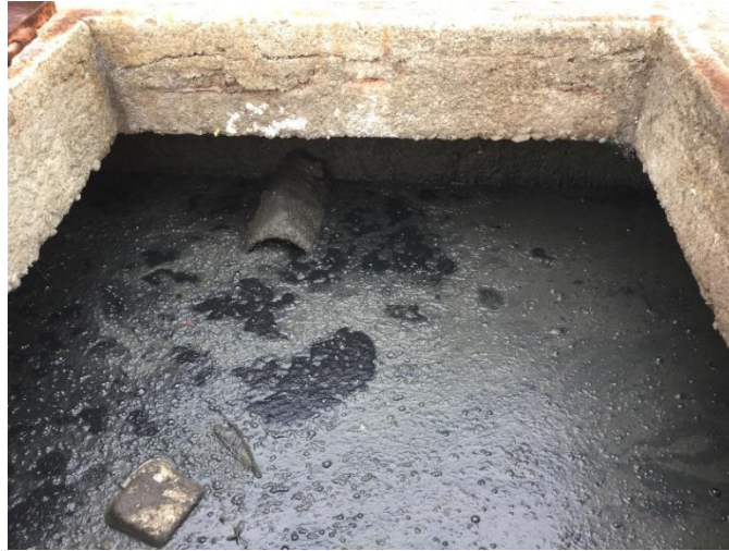
Gráfico 5.8. Sólidos que ingresan al tanque séptico.
