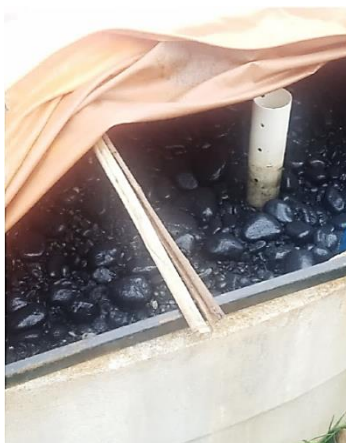
Gráfico 5.14. Medio de empaque del Filtro Anaerobio.
