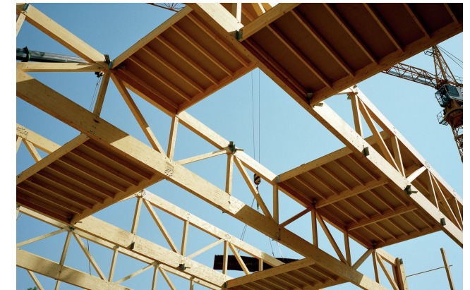
Foto 2.4 : Cubierta del Gimnasio Fuente: Pag web Plataforma Arquitectura
