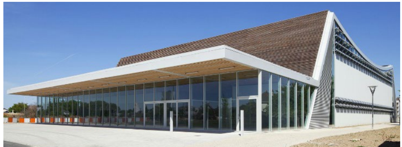
Foto 2.32 : Vista exterior del coliseo Fuente: Pagina oficial Explorations Architecture
