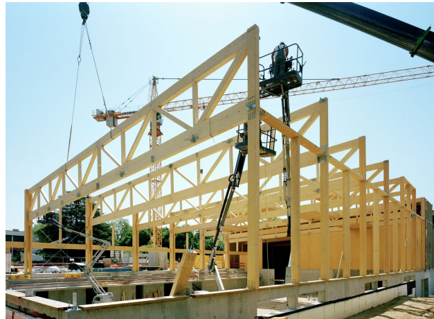
Foto 2.13: Construcción del Gimnasio Fuente: Pag web Plataforma Arquitectura
