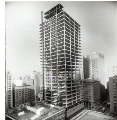
Foto 1.9: Edificio en construcción. Fuente: https://foffaniceciliaim2013.wordpress.com
