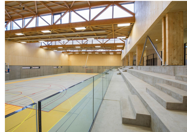
Foto 2.15 Estructura del Gimnasio Fuente: Pag web Plataforma Arquitectura
