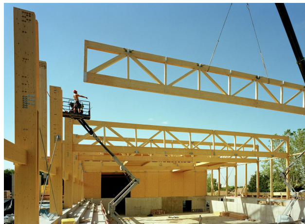
Foto 2.14: Construcción del Gimnasio Fuente: Pag web Plataforma Arquitectura
