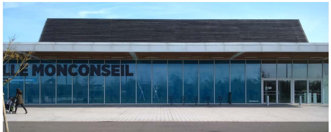
Foto 2.33 : Vista exterior del coliseo Fuente: Pagina oficial Explorations Architecture
