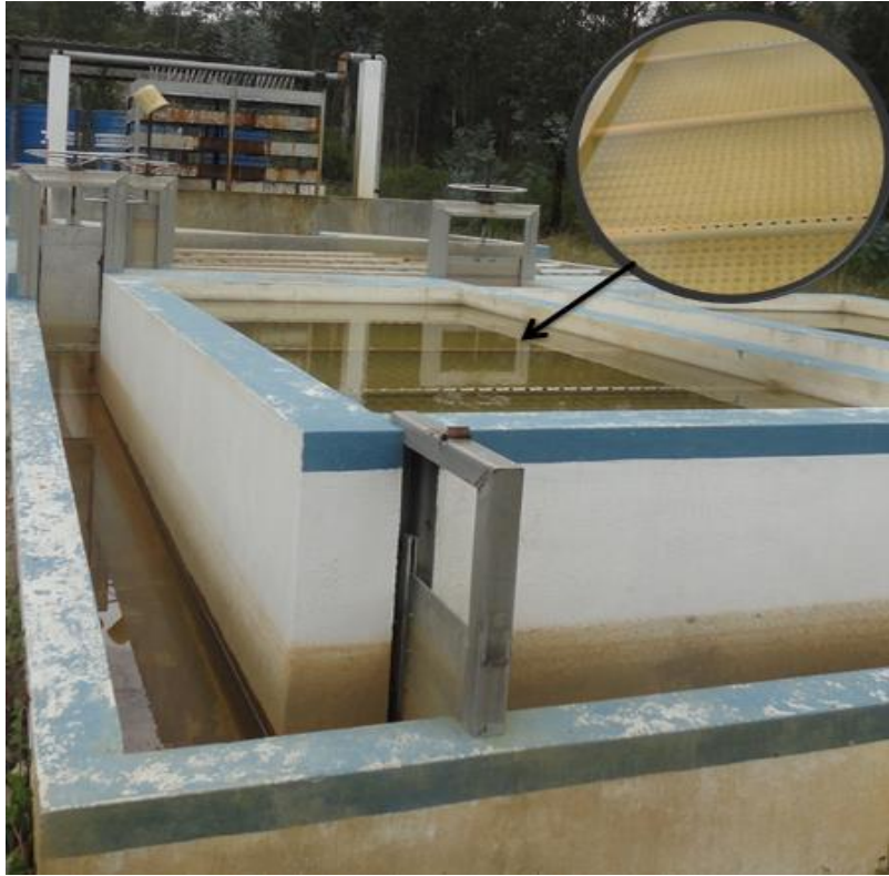
Figura 3.6 Sedimentadores. Fuente el Autor
