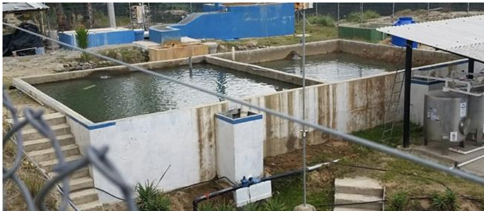
Figura 3.8 Filtros de arena. Fuente el Autor
