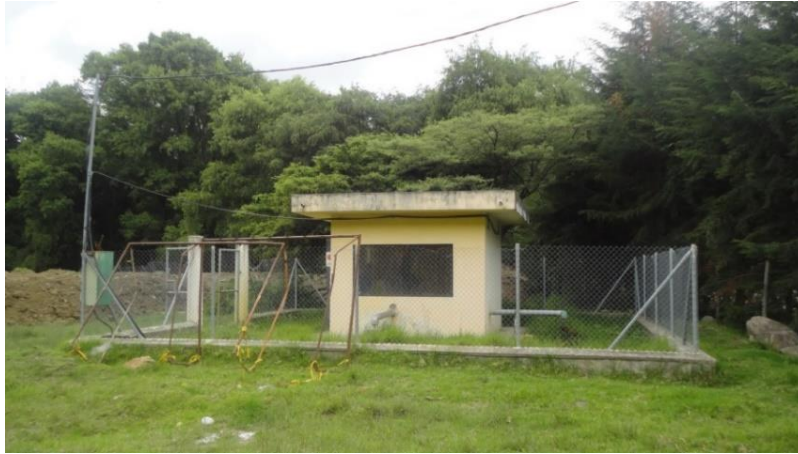
Figura 3.1 Estación de Bombeo El Descanso. Fuente el Autor
