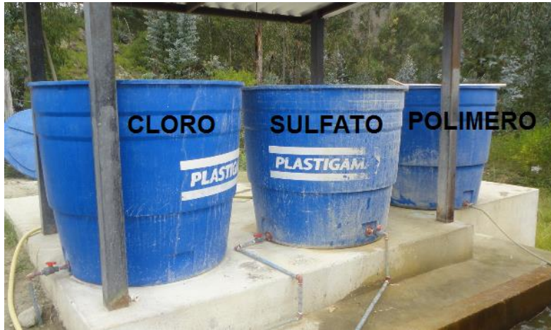
Figura 3.4 Dosificación de insumos químicos (tanque A, B y C). Fuente el Autor
