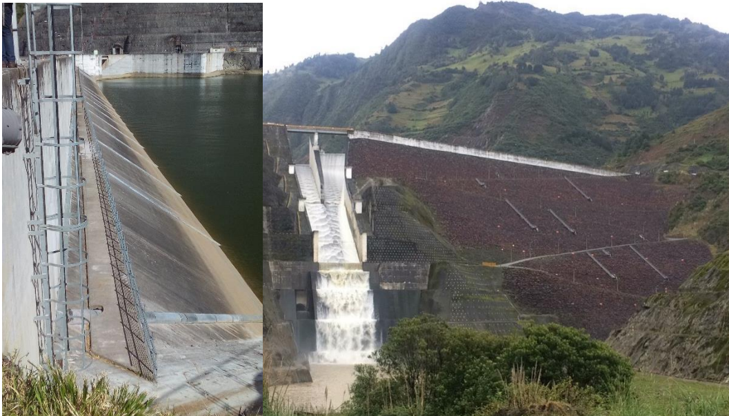
Figura 23 Vista de Pantalla y Enrocado de Presa Mazar. (Elaboración Propia)
