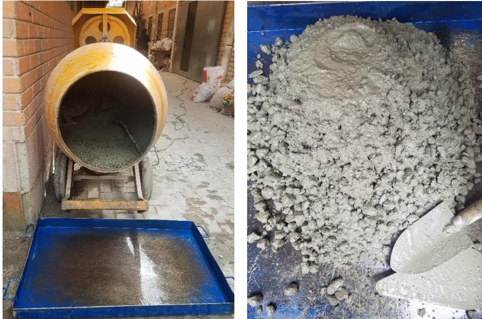
Ilustración 12 Proceso de Mezclado – Mezcla de hormigón en fresco
