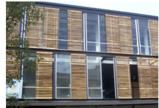
F45: CENTRO COMERCIAL 9 DE OCTUBRE
