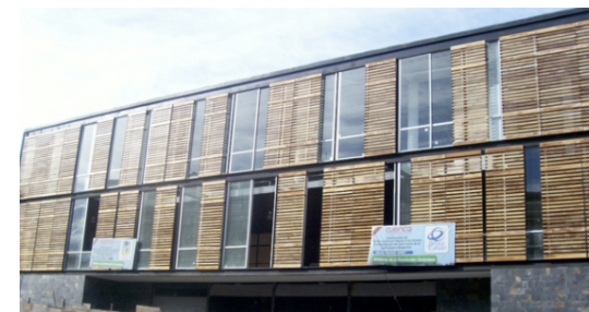
F46: CENTRO COMERCIAL 9 DE OCTUBRE
