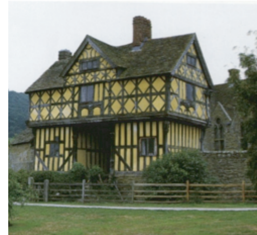
F3: Casa con entramado de madera
