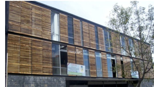
F44: CENTRO COMERCIAL 9 DE OCTUBRE
