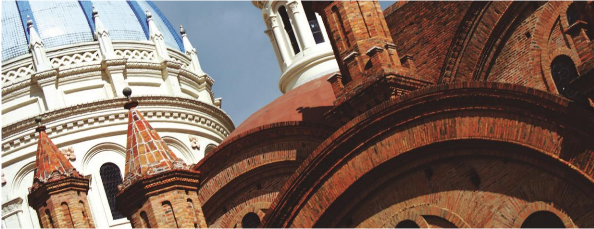
Patrimonio Tangible: la arquitectura
