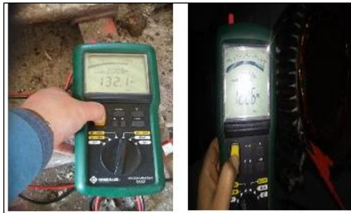
Figura 5.1-16. Pruebas de aislamiento antes y después
