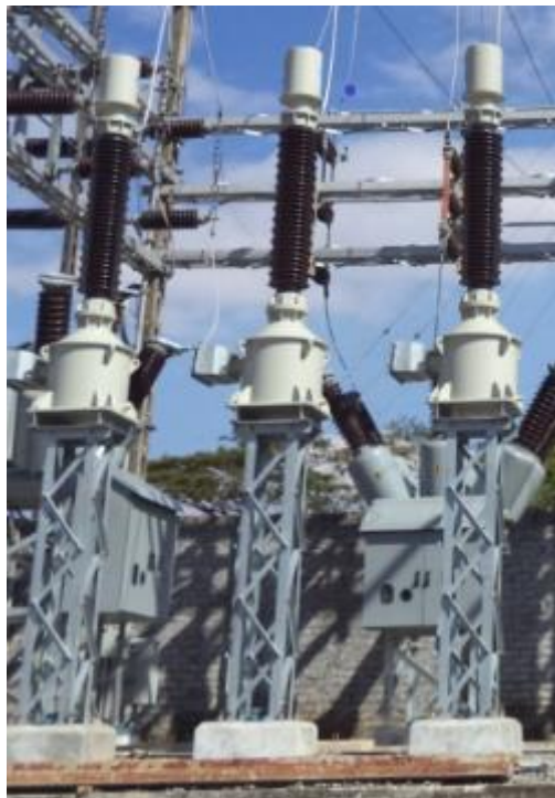
Figura 3.3. Transformador de potencial.
