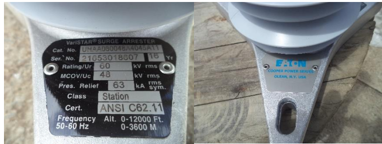
Figura 4.11. Pararrayos para las salidas en las tres bahías en 69kV.
