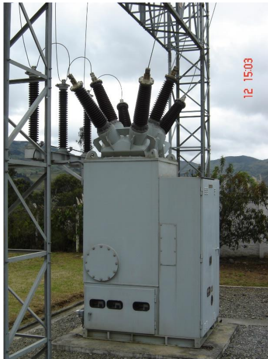
Figura 3.5. Interruptor de potencia.
