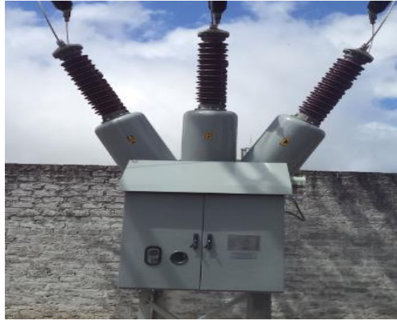
Figura 4.11. Interruptor tanque muerto con gas SF6.
