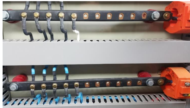
Figura 4.17. Barras para el voltaje AC.
