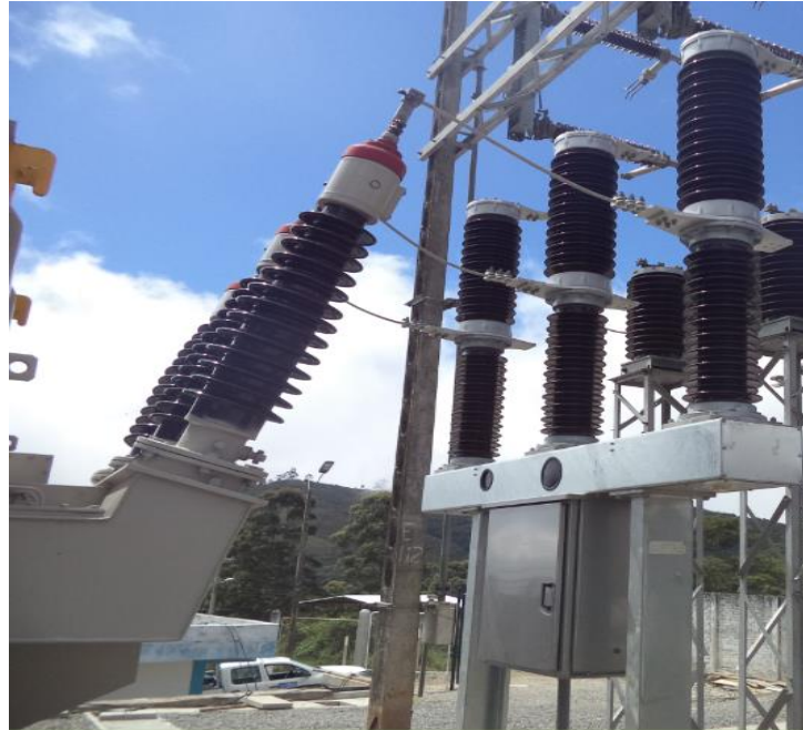
Figura 4.7. Interruptor tanque vivo en SF6.
