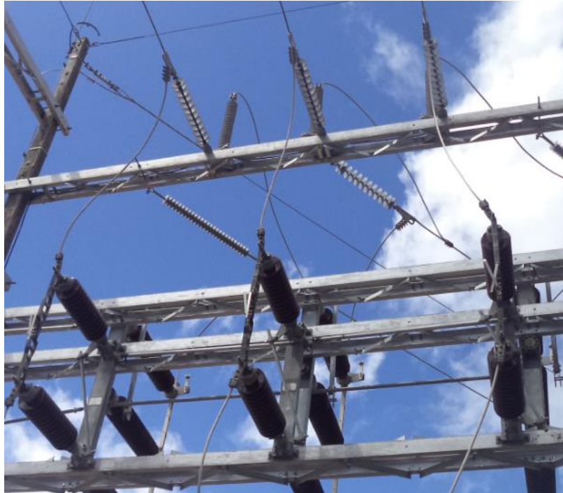
Figura 4.10. Seccionador tripolar con mando mecánico
