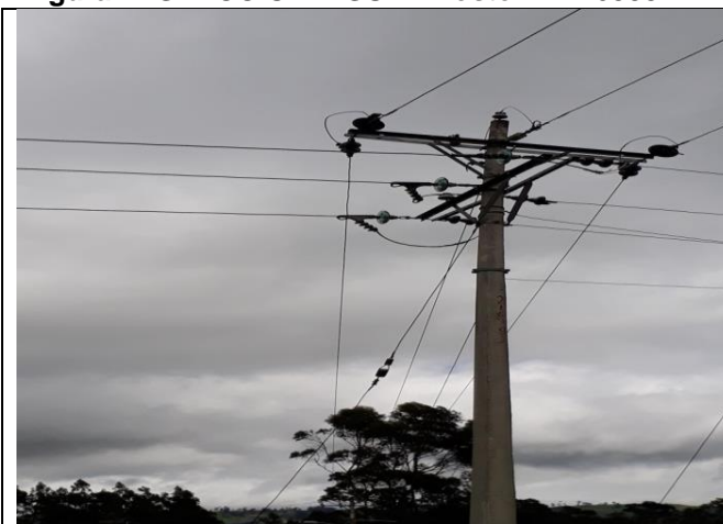
Figura. INSPECCION VISUAL Poste N° 216383
