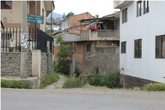
Fotografía 12 Estado de la quebrada en la Av. Ordoñez Laso. Elaboración propia, 2017.
