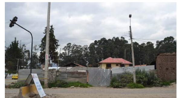
Fotografía 11 Casa derrumbada entre la Av. Ordoñez Laso y Av. de los Cerezos. Elaboración propia, 2016.
