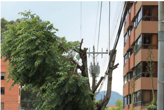
Fotografía 13 Infraestructura en la Av. Ordoñez Laso. Elaboración propia, 2017.
