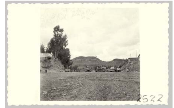
Fotografía 6 Vista hacia Turi desde la futura Av. Solano. Repositorio del INPC
