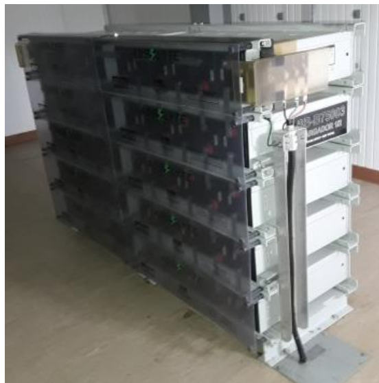
FIGURA 1.33: : Banco de baterías de cuarto de control SPF OSOB
