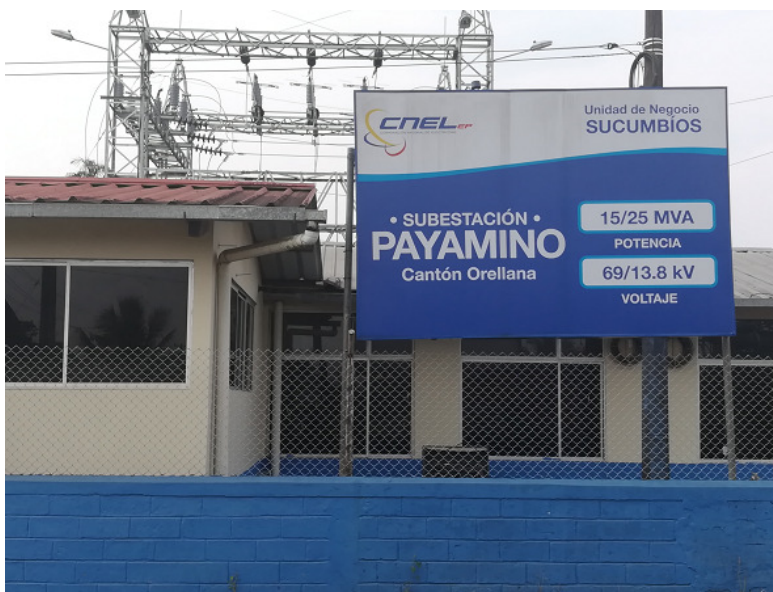
Figura 4.4 Exterior de la Subestación Payamino.
