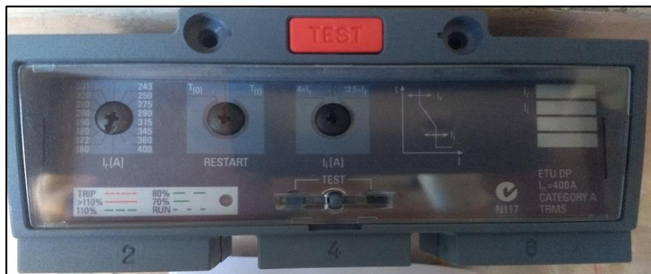
Figura 4.35 Unidad de disparo de breaker termo-magnético SIEMENS. (Fuente autores)
