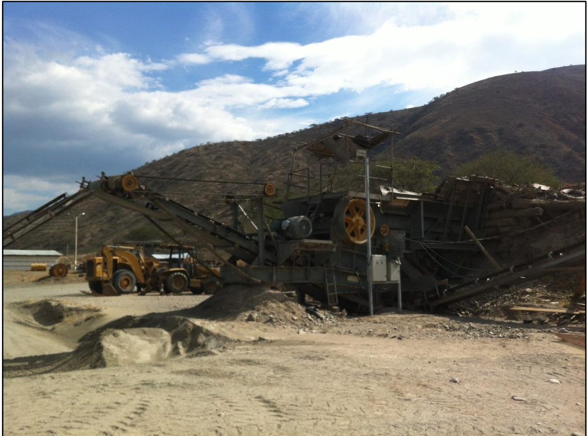
Figura 4.5 Planta Trituradora 2. (Fuente autores)
