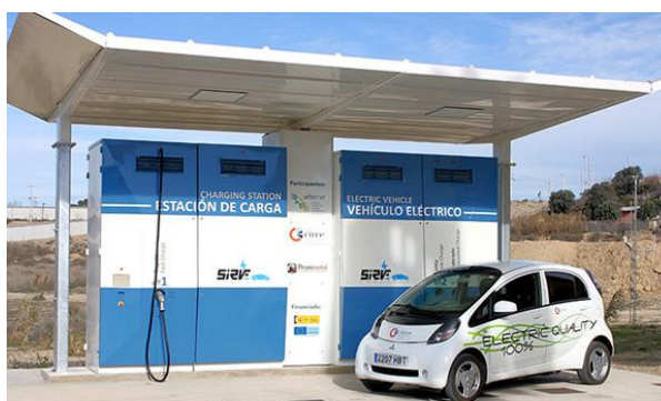
Figura 2.2: Estación de carga para vehículos eléctricos ( Híbridos y Eléctricos )
