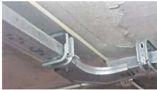
Figura 7. Bandejas metálicas. [6]
