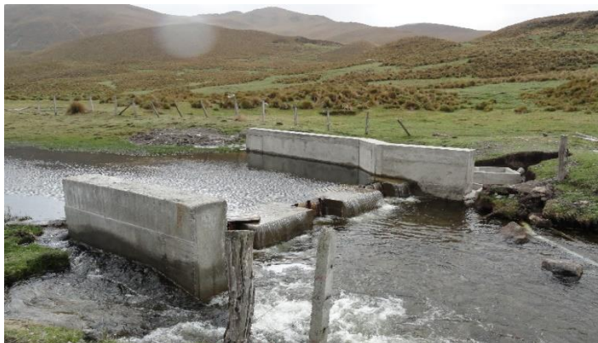
Figura 4.13 Captación del Río San Antonio.
