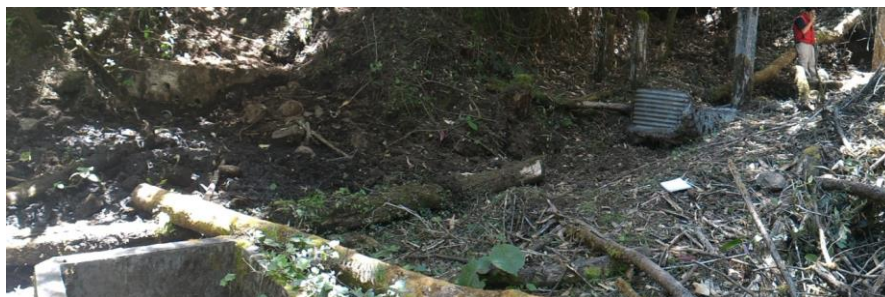
Figura 4. 19 Captación 1 (GAD Suscal, 2015).
