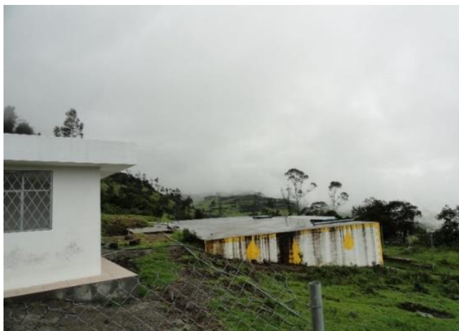
Figura 4. 24 Tanque de 450 m 3 de capacidad.
