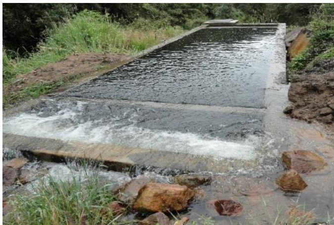
Figura 4. 7 Desarenador del Sistema Cachi.
