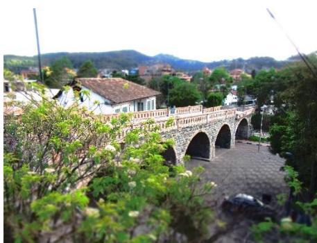
Fotografía 47: Puente Roto Fuente: Autor
