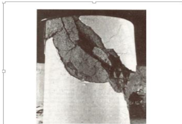
Figura 2.2 Falla por tensión diagonal en columna zunchada (Tomado de Alves R; Soares de Souza A, 2014).
