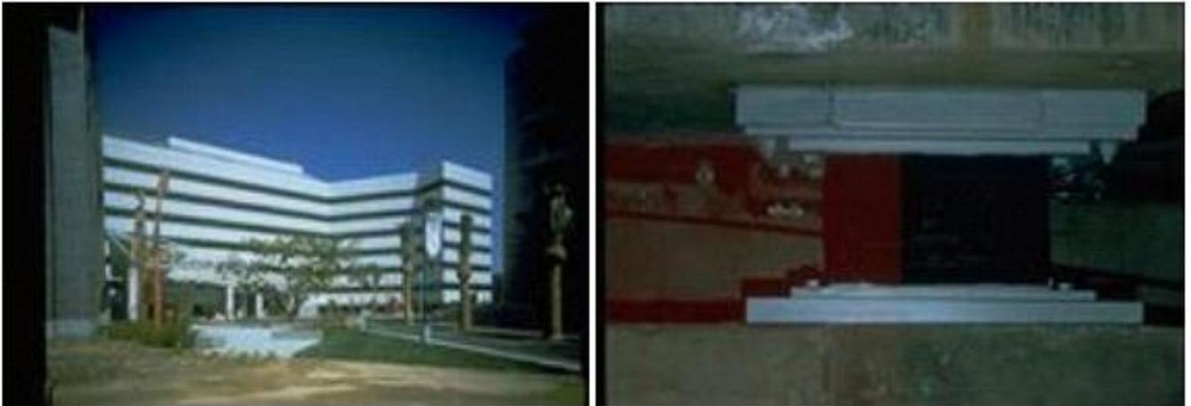
*Figura 4: Buen desempeño de un edificio que contaba con sistema de aislamiento basal durante el sismo de Northridge [8].*
