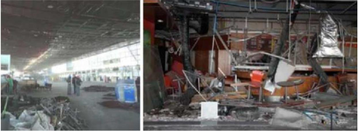
**Figura 1:** Daños en componentes no estructurales en el aeropuerto internacional de Santiago, Chile. Se puede observar que la estructura está intacta pero los CNE han sufrido mucho daño [3].
