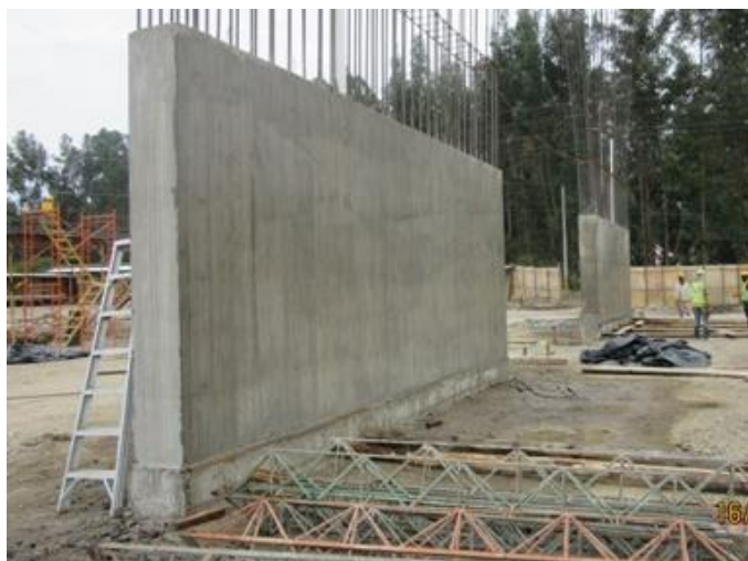
Ilustración 11. Hormigón premezclado f'c=300 \text{ kg/cm}^2
