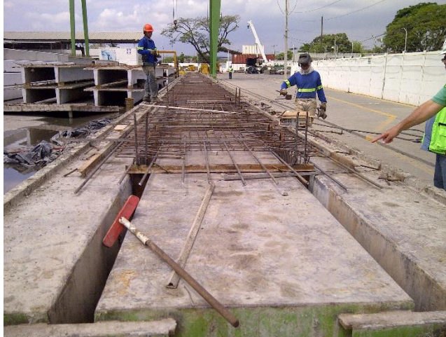
Ilustración 12. Elaboración del hormigón pretensado, en la fábrica MAVISA ubicada en Guayaquil
