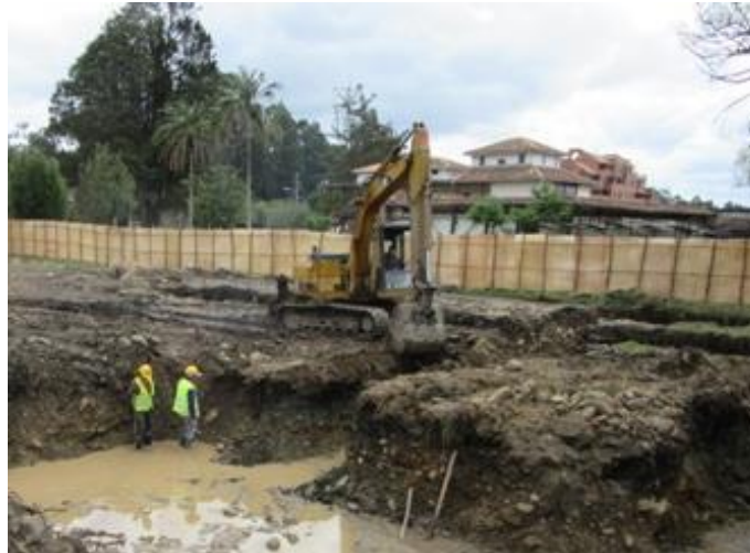
Ilustración 5. Excavación mecánica en suelo conglomerado de 2 a 4 m de profundidad
