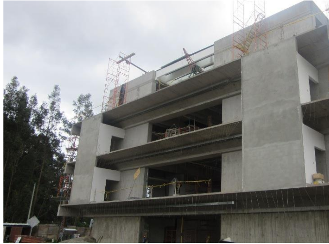
Ilustración 21. Enlucido con mortero 1:3
