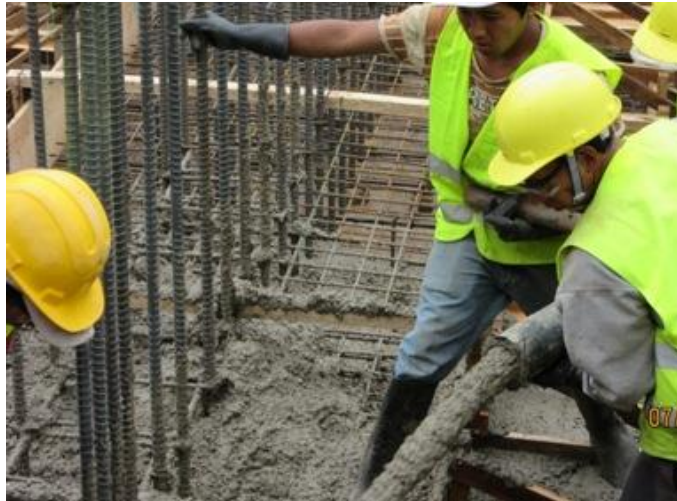
Ilustración 10. Hormigón premezclado f'c=250 \text{ kg/cm}^2
