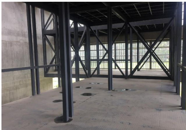
Ilustración 19. Suministro e instalación de Estructura Metálica (A36) en el Orquideario
