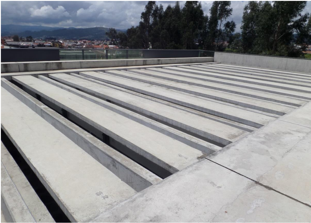
Ilustración 47. Hormigón pretensado, vista superior
