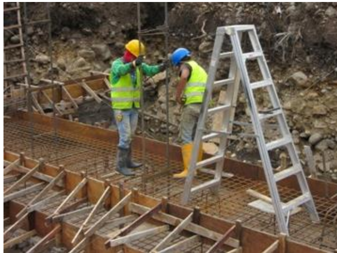
Ilustración 16. Suministro e instalación de malla electrosoldada
