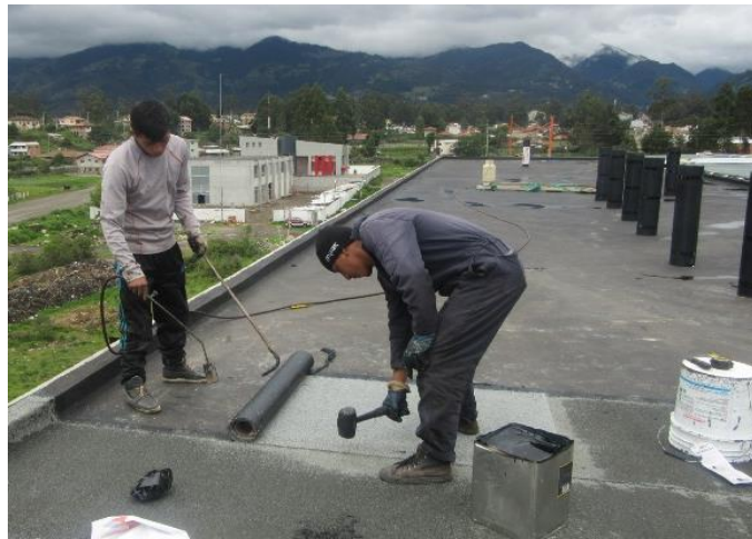
Ilustración 24. Impermeabilización de losa de cubierta
