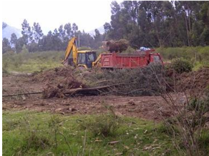
Ilustración 2. Desbroce y limpieza
