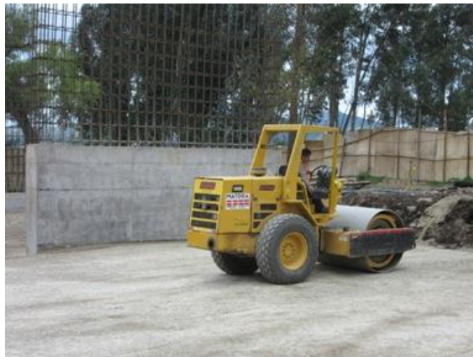
Ilustración 6. Relleno compactado con material de mejoramiento usando rodillo compactador
