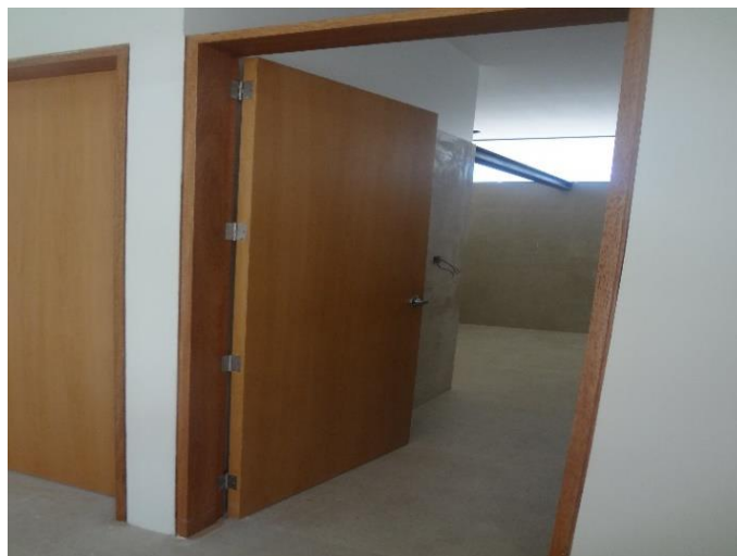
Ilustración 26. Puerta de madera 1.30 x 2.10 m con lana de vidrio (acústicas)
