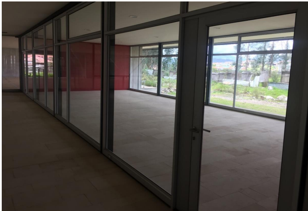
Ilustración 54. Puertas, ventanas y mamparas elaboradas en perfiles de aluminio y vidrio (Interiores, planta baja)
