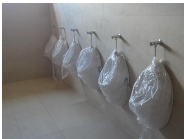
Ilustración 29. Suministro e instalación de Urinarios con grifo temporizado
