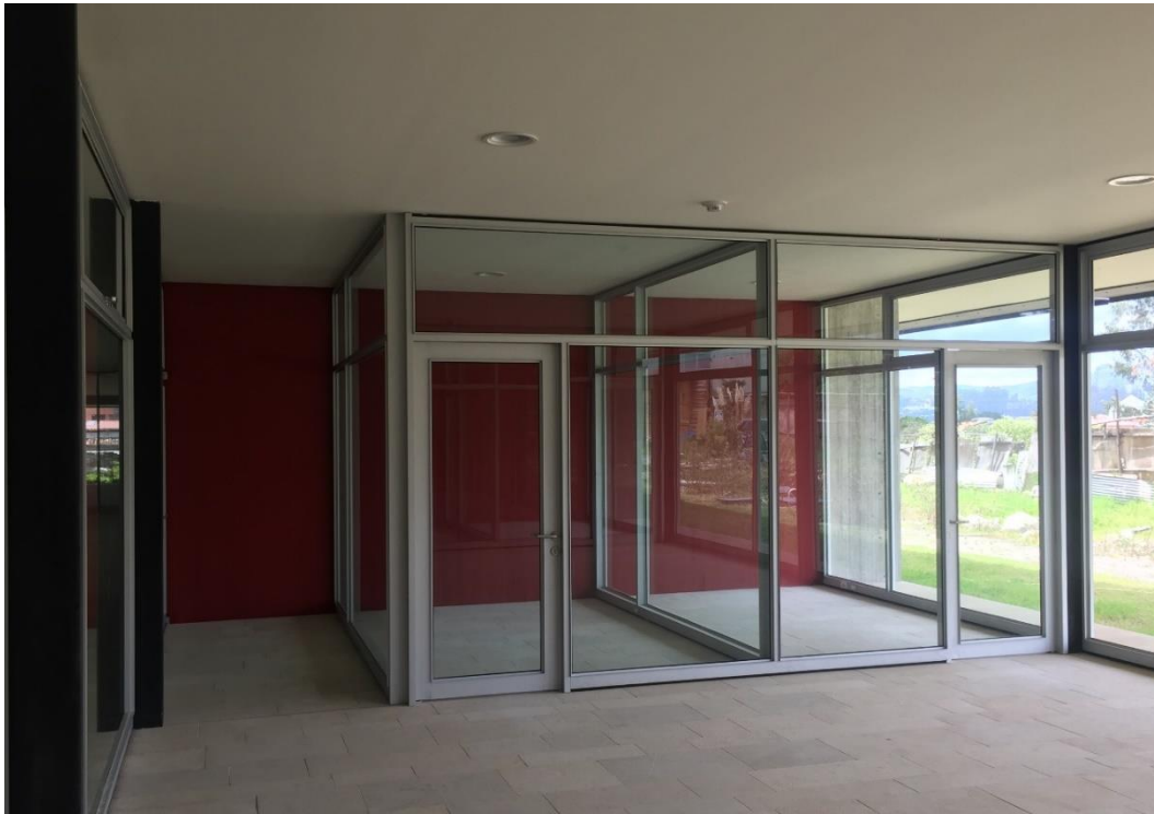
Ilustración 55. Puertas, ventanas y mamparas elaboradas en perfiles de aluminio y vidrio (Interiores, planta baja)
