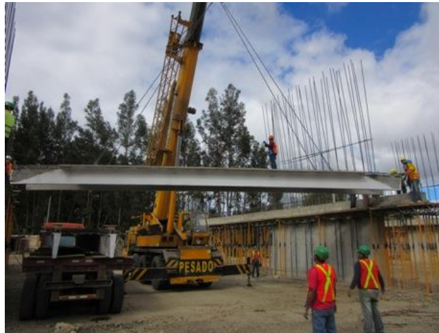
Ilustración 14. Hormigón pretensado 400 kg/incluye refuerzo, montaje.
