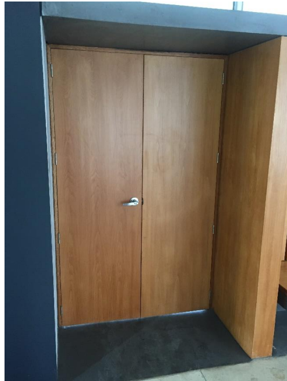
Ilustración 57. Puerta de Madera
