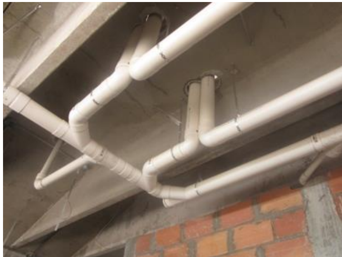
Ilustración 32. Suministro e instalación de tubería de PVC para desagüe \varnothing=110\text{mm}
