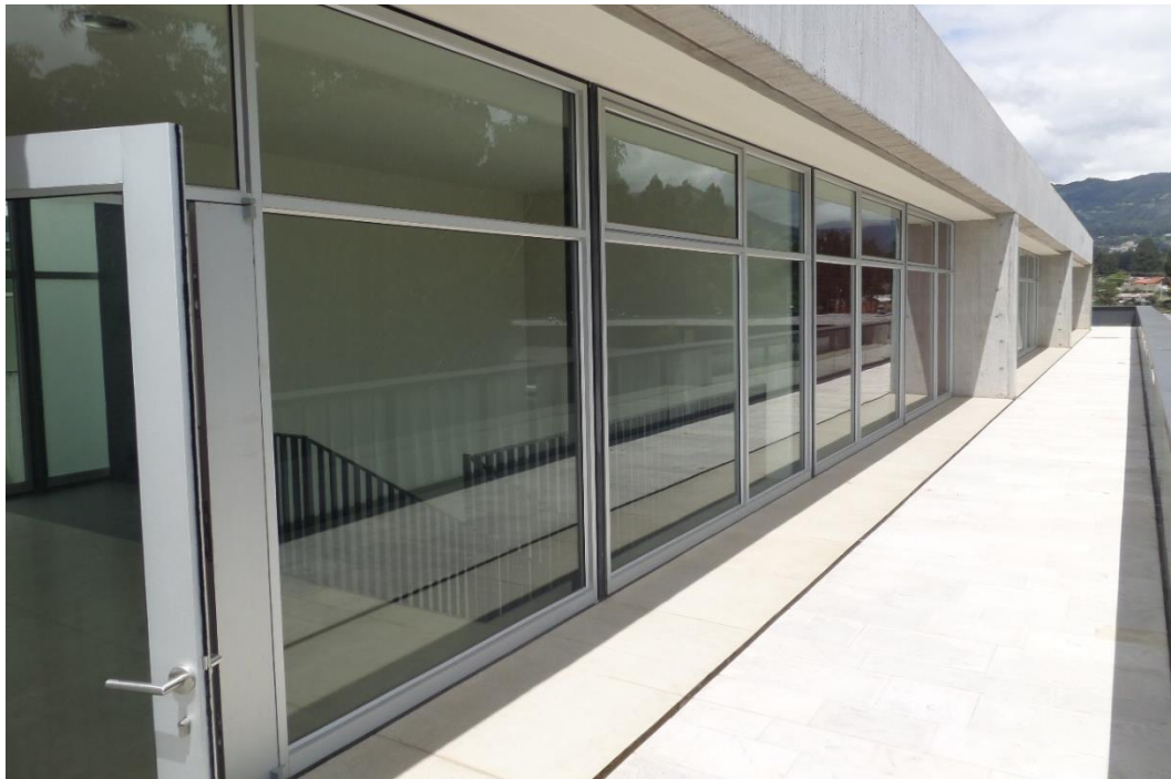
Ilustración 53. Puertas, ventanas y mamparas elaboradas en perfiles de aluminio y vidrio (Exteriores, tercera planta alta)
