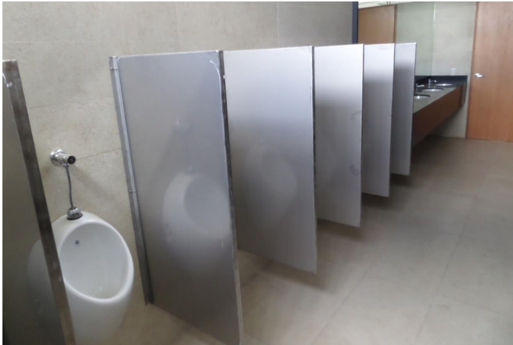
Ilustración 59. Urinarios con grifo sincronizado
