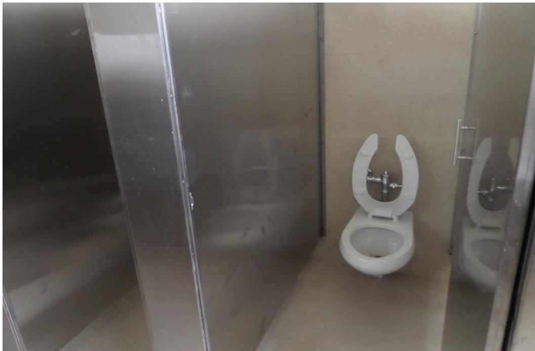
Ilustración 60. Inodoro con Fluxómetro
