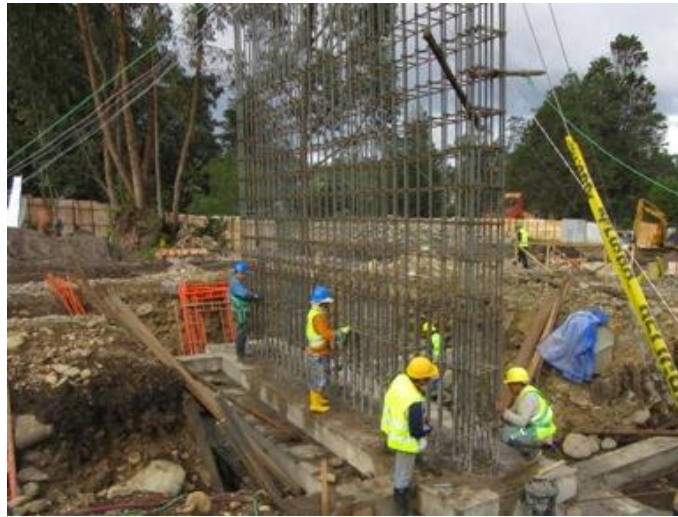
Ilustración 15. Acero de refuerzo (corte, doblado y colocación) fy 4200 kg/cm 2
