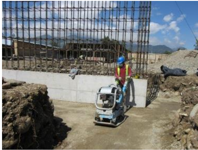
Ilustración 7. Relleno compactado con material de mejoramiento usando un vibro apisonador
