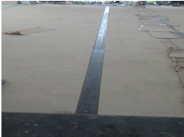
Ilustración 18. Suministro e instalación de Estructura Metálica (A50) en pisos
