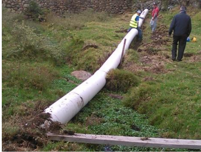
Ilustración 31. Suministro e instalación de tubería de PVC para desagüe \varnothing=315\text{mm}
