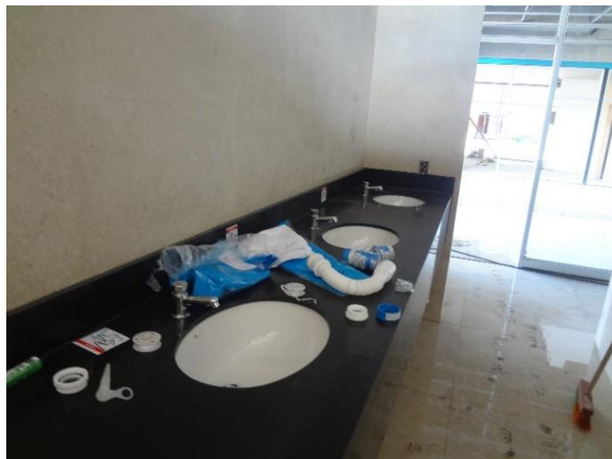
Ilustración 28. Suministro e instalación de Lavamanos (incluye llave presmatic)
