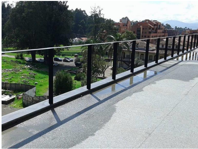
Ilustración 17. Suministro e instalación de Estructura Metálica (A50) en barandas
