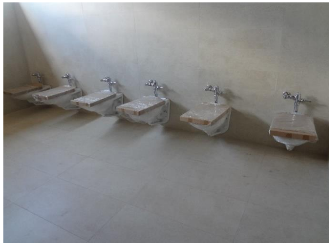
Ilustración 30. Suministro e instalación de inodoro con fluxómetro
