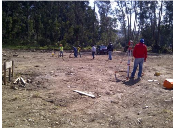
Ilustración 3. Replanteo y nivelación de áreas
