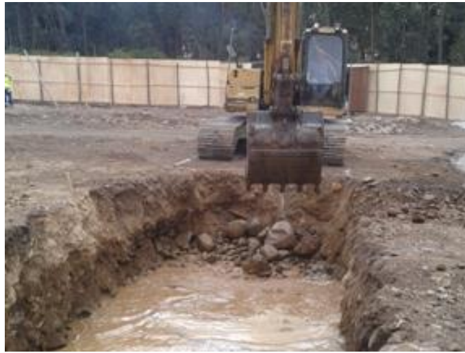
Ilustración 4. Excavación mecánica en suelo conglomerado de 0 a 2 m de profundidad
