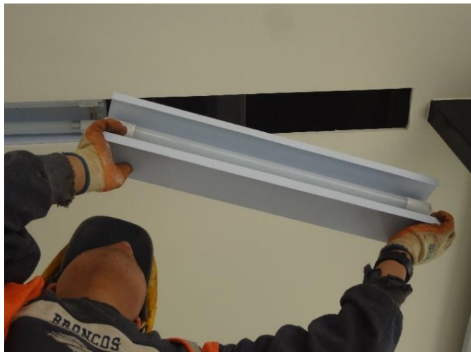
Ilustración 35. Colocación de Luminaria para adosar T8 con lámparas LED de 1x20 W con difusor de vidrio frontal
