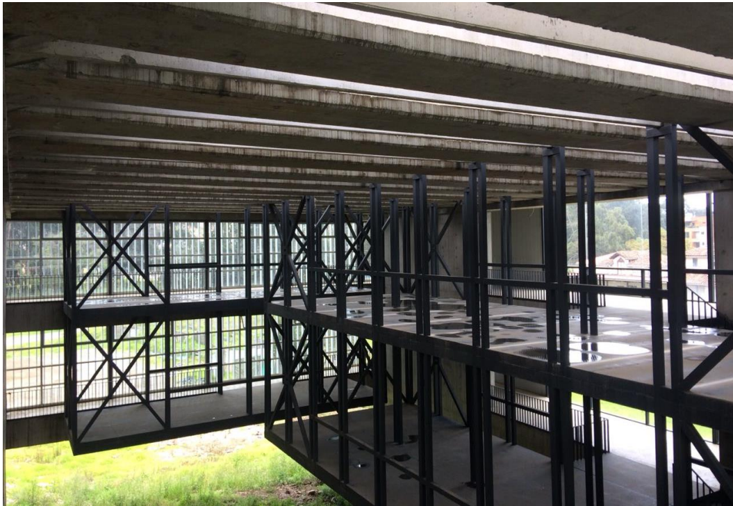
Ilustración 67. Estructura Metálica (A50), Orquideario (Vista Superior)
