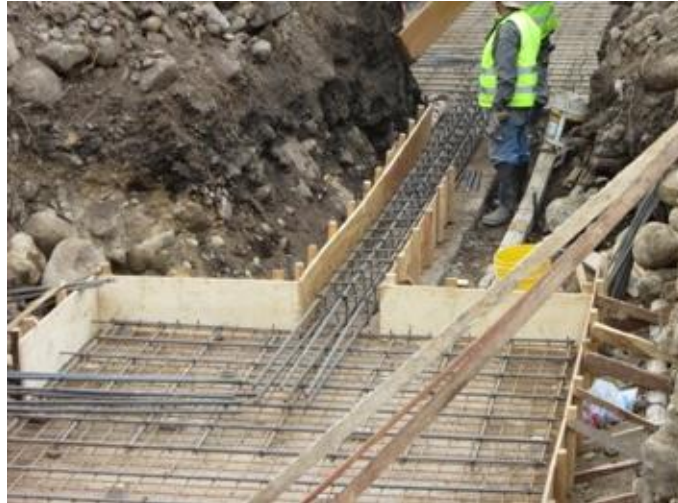
Ilustración 8. Encofrado recto
