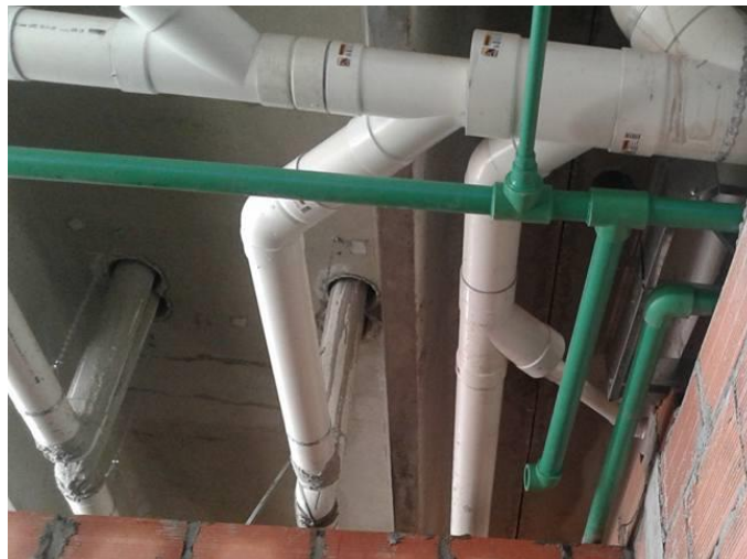
Ilustración 27. Suministro e instalación de tubería PVC \varnothing 40 mm 1,25 Mpa
