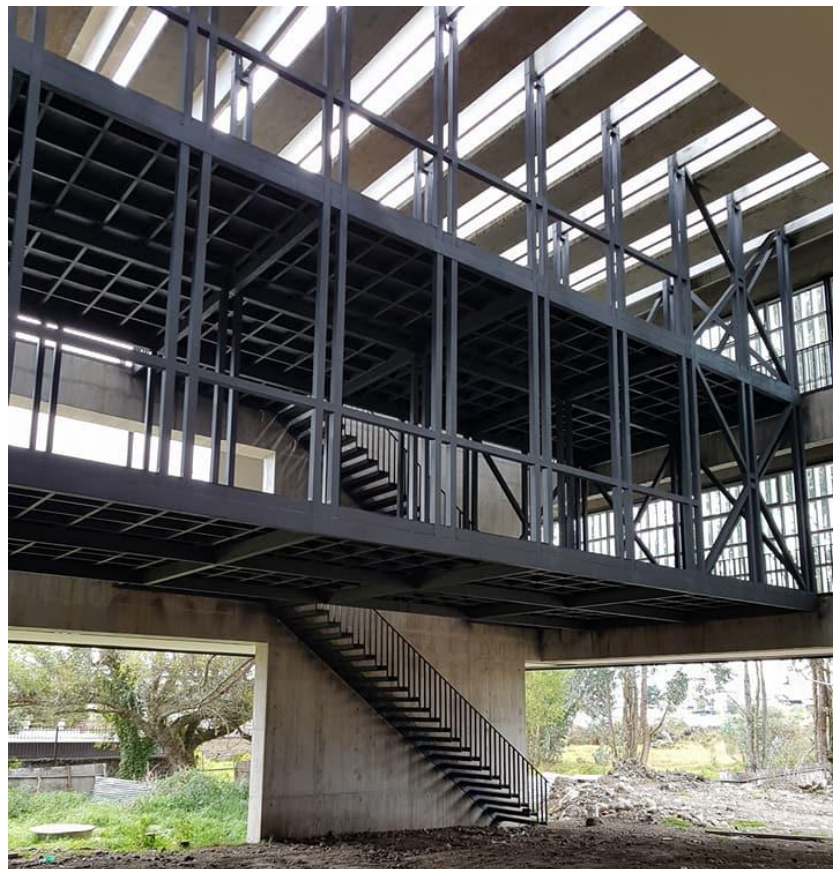
Ilustración 66. Estructura Metálica (A50), Orquideario (Vista Inferior)
