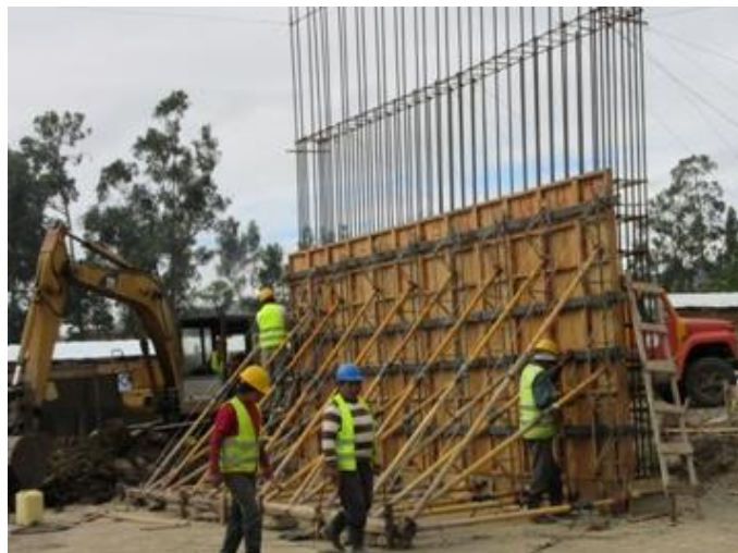
Ilustración 9. Encofrado para elementos vistos y apuntalamiento
