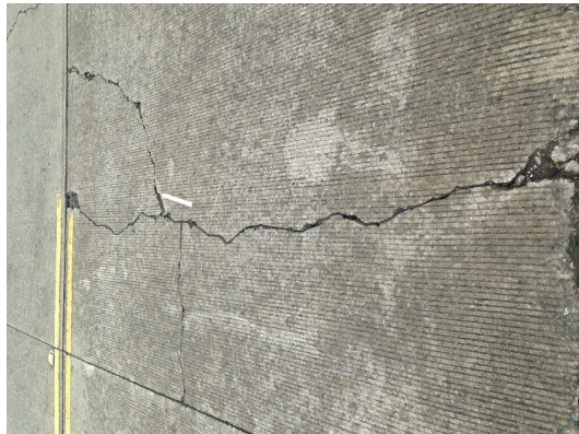
(c) Punzonamiento. Severidad Media
