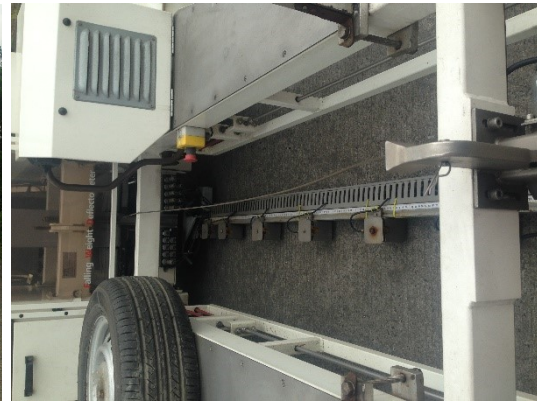
(b) Sensores de medición de deflexiones (Geófonos). Vista superior.
