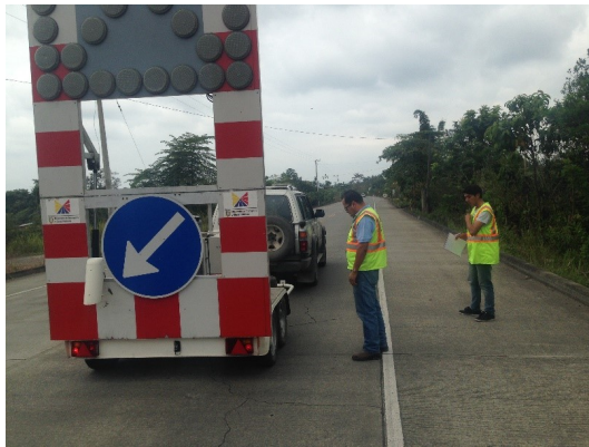
(a) Evaluación estructural utilizando el deflectómetro de impacto
