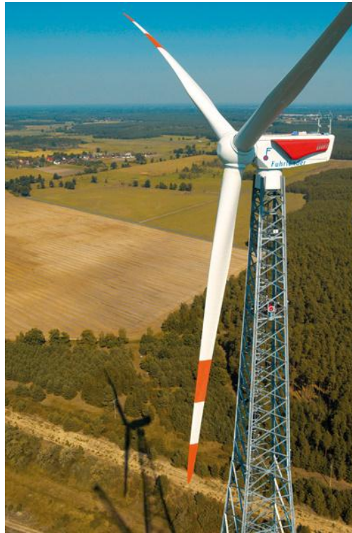
Figura 1.20: Aerogenerador sobre torre de celosía
