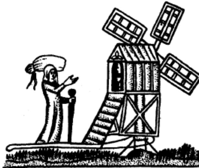
Figura 1.7: Molino de viento de poste (grabado de la época)
