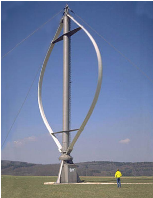
Figura 1.12: Izquierda: Aerogenerador con rotor Darrieus. Derecha: Aplicación de aerogenerador con rotor Darrieus
