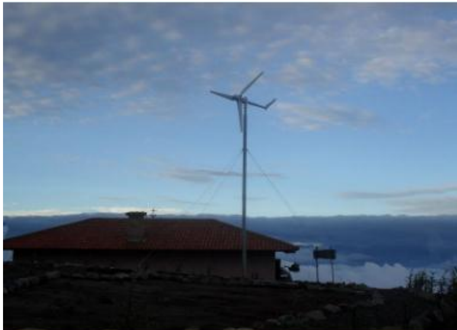
Figura 2.15: Aerogenerador en Garupamba
