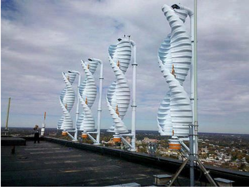
Figura 1.11: Aerogenerador Savonius
