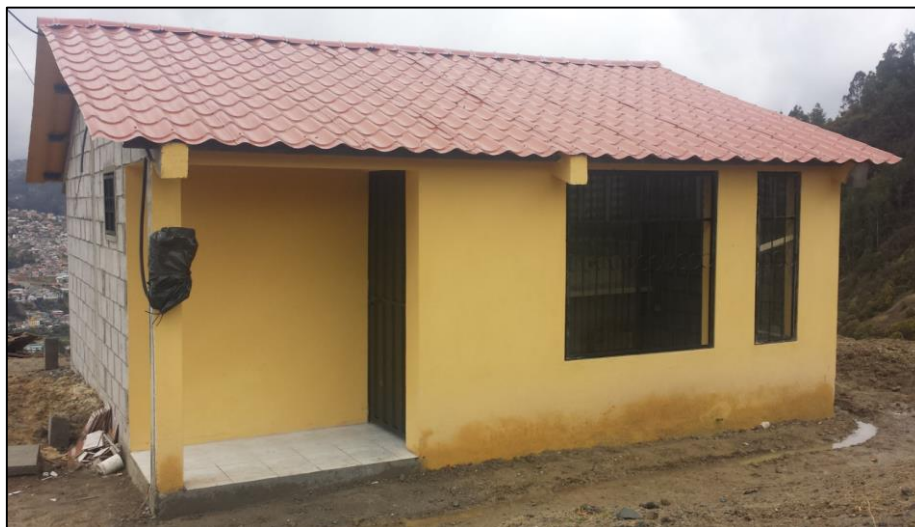
Imagen 1. Vivienda terminada del proyecto Quillopungo, Fuente: MIDUVI (2014).
