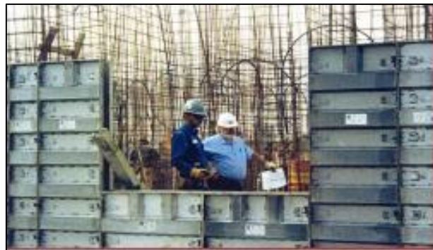
Imagen 3. Encofrado del muro con formaletas especializadas. Recuperado a partir de construirfuturo.ec (2016).
