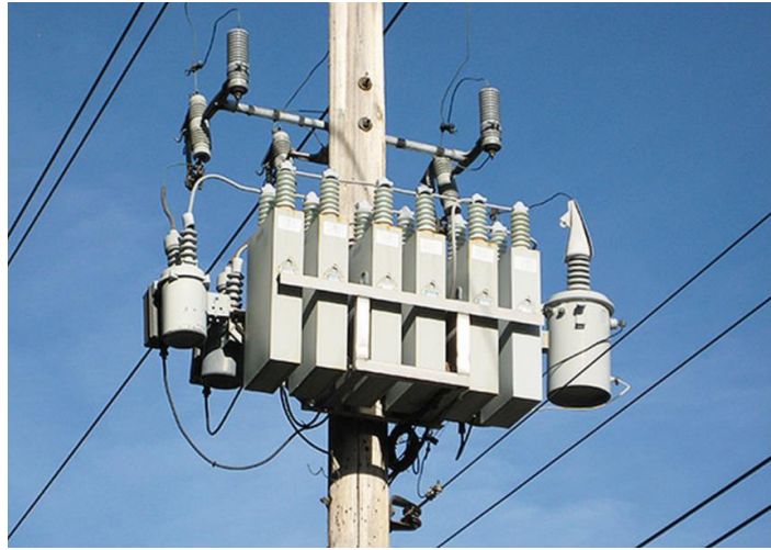
Figura 2-3. Banco de capacitores en red de media tensión [5]
