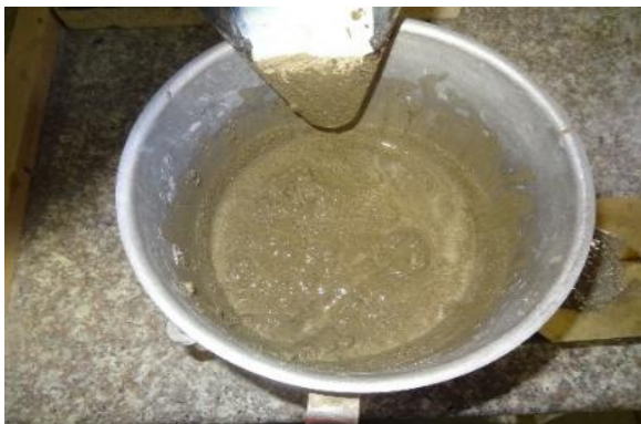
Ilustración N° 55: Preparación de mortero en batidora eléctrica
