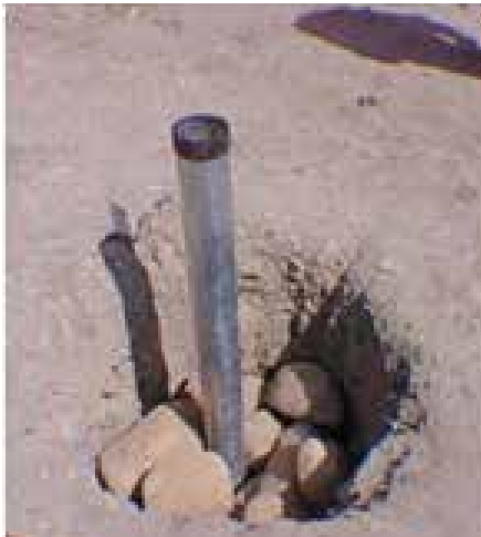
Figura 4 y 5. Construcción de chimeneas.
