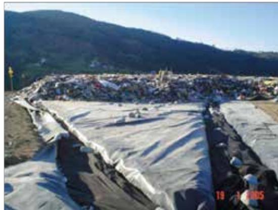
Figura 1 y 2. Construcción de los drenajes del relleno sanitario de Pichacay
