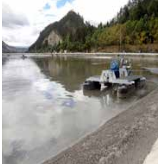
Figura 4. Lagunas aeradas; motor nuevo para aeración.
