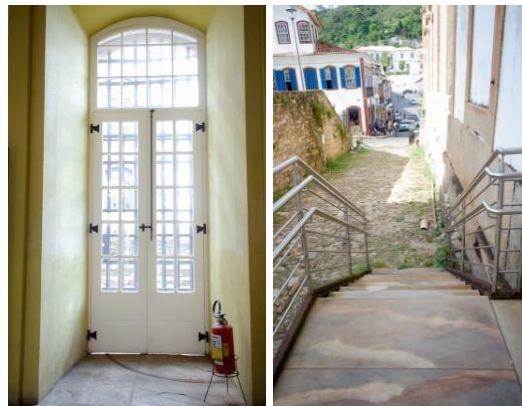
Figuras 3 y 4: A la izquierda: Puerta de madera de acceso a la rampa. A la derecha: La rampa de acceso. (2016)
