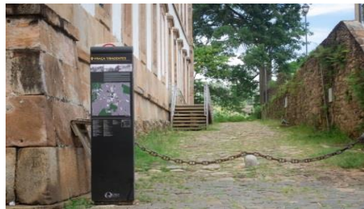
Figura 2: Entrada por el lateral derecho del edificio y cadena indicando la restricción del paso (2016)
