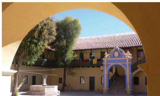
Figura 1 (superior): Estado inicial del patio. Figura 2 (inferior): Estado final desde el patio central del edificio luego de la intervención en el Pabellón de los Oficiales Reales.
