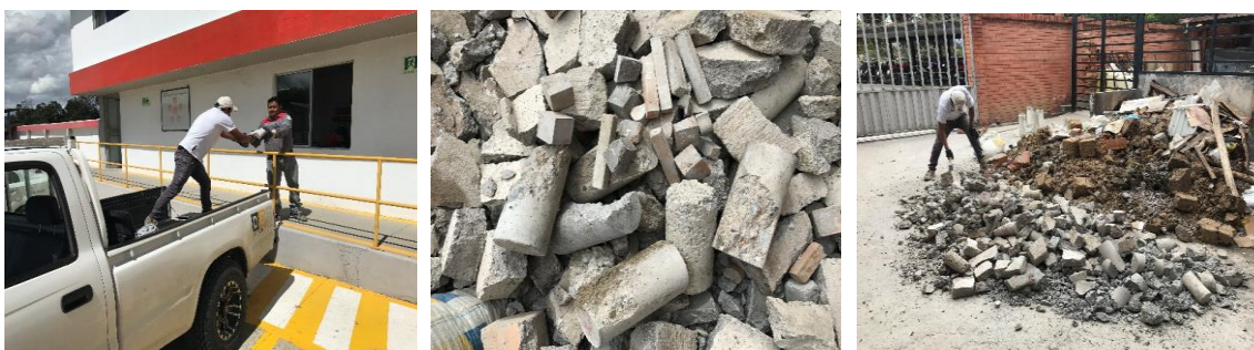
Figura 25. Acopio de residuos de hormigón. (Autor. 2017)
