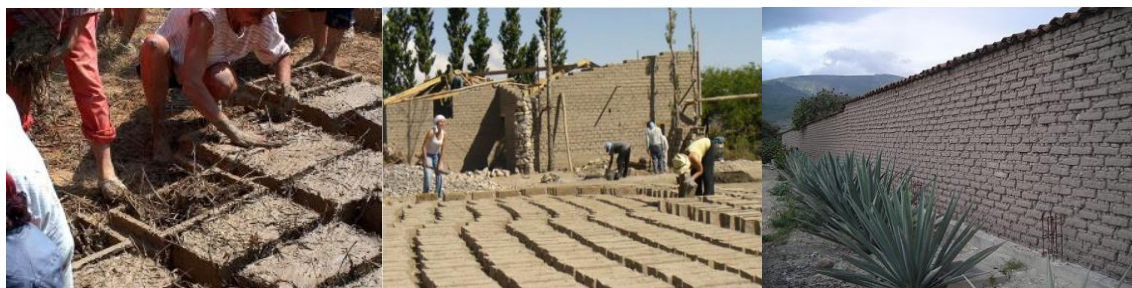
Figura 12. Fabricación de adobes. Fuente: (ECYT-AR, 2014)
