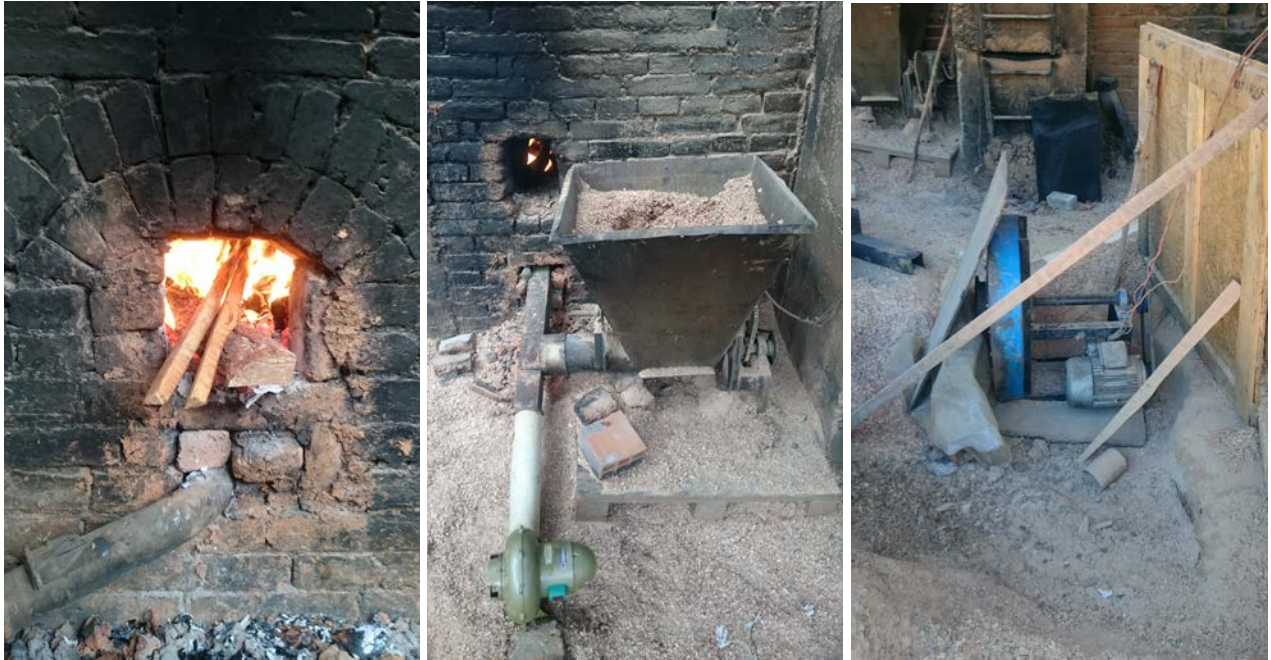
Figura No. 10 Punto de suministro de leña (izquierda). Punto de suministro de aserrín (centro) Ventilador de velocidad regulable (derecha). Fuente: Autor
