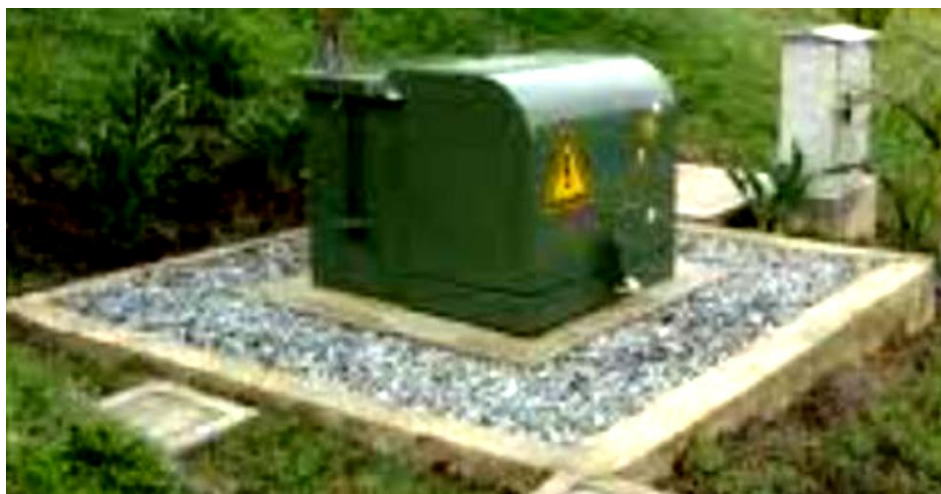
Ilustración 5.15. Transformador Padmounted
