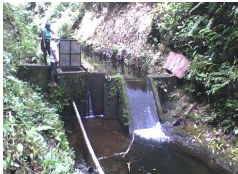
Gráfico 1. Captación de la planta de tratamiento
