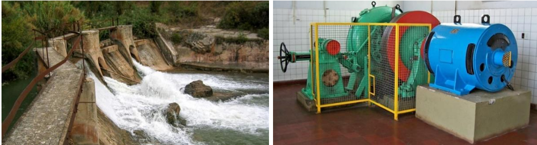
Figura 2.3.7 Central mini hidroeléctrica. (Fuente: http://www.innovaticias.com/tecnologias/8278/mini-hidraulica-renovables-energia-curso-seas ).
