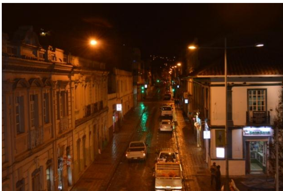
Figura 4.2 Foto de una de las calles antes del mantenimiento [8]
