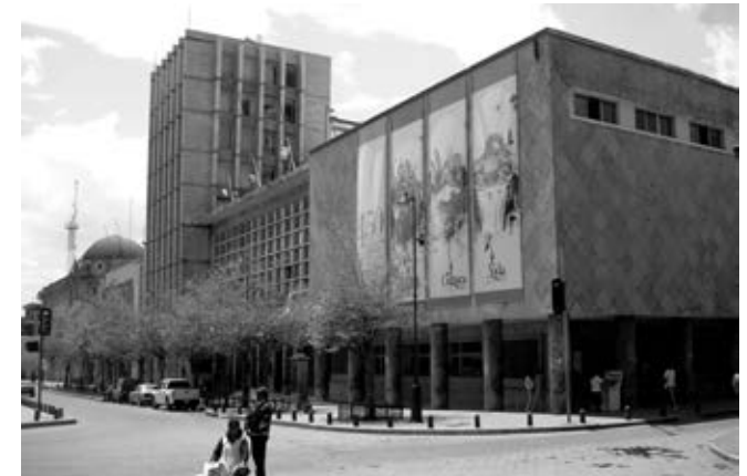
Figura 34: Perspectiva vertical del Municipio de Cuenca Fuente: Arquitectura moderna en Cuenca - Ecuador, Mogrovejo F., 2008
