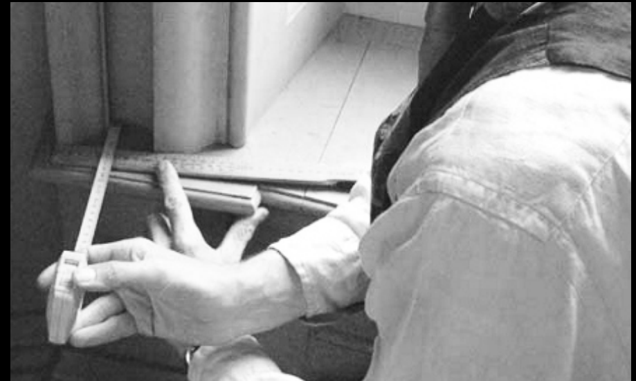
Figura 9: Medición manual a detalle de edificaciones patrimoniales Fuente: Bill Blake, Billboyheritagesurvey's Blog , 2017
