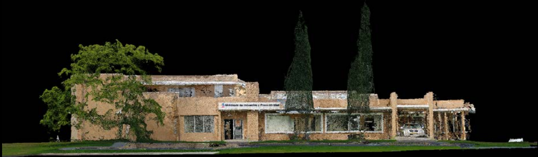
Figura 101: Fachada frontal de la Casa Peña mediante fotogrametría Fuente: Autores, 2017
