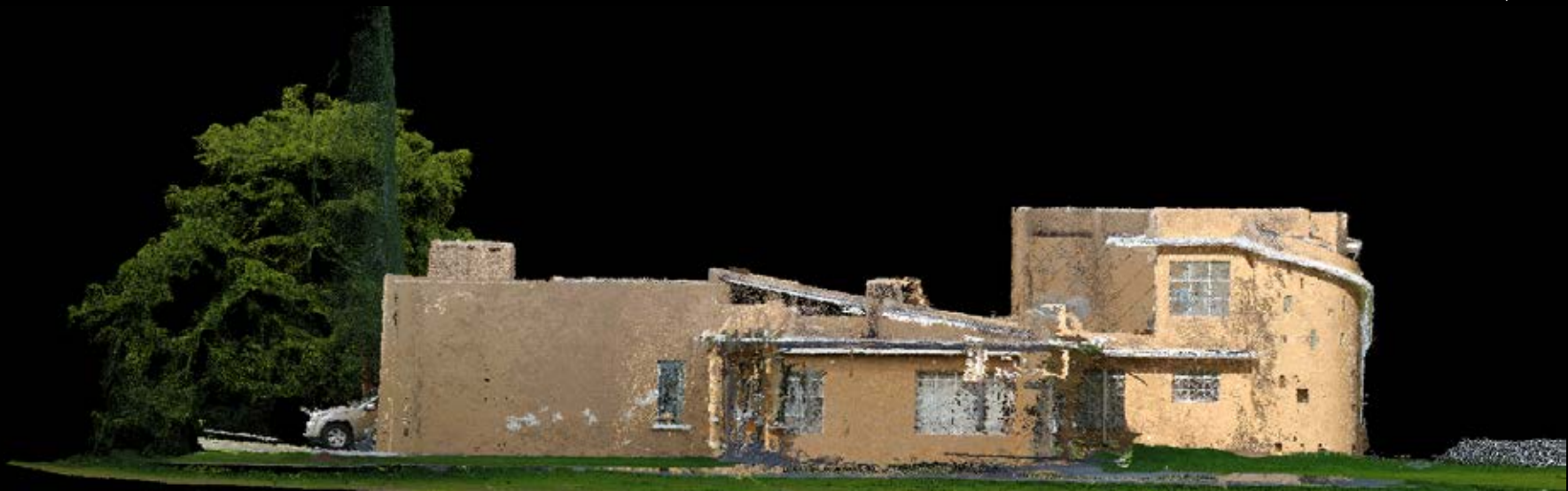
Figura 102: Fachada lateral derecha de la Casa Peña mediante fotogrametría Fuente: Autores, 2017
