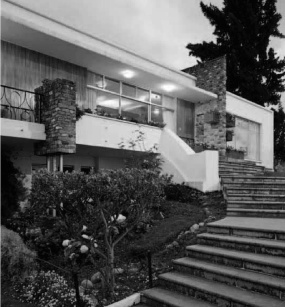
Figura 41: Perspectiva frontal de la Casa Vázquez Fuente: Revista Proyectos N°1, Vivienda unifamiliar 1960 - 1979, Colegio de Arquitectos del Azuay, 2007
