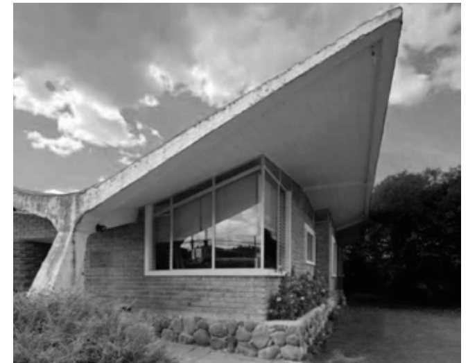
Figura 40: Perspectiva lateral de la Casa Peña Fuente: Revista Proyectos N°1, Vivienda unifamiliar 1960 - 1979, Colegio de Arquitectos del Azuay, 2007
