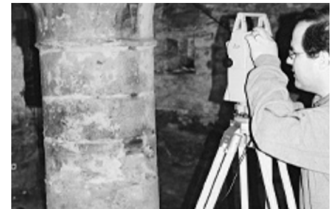
Figura 21: Registro de construcción con estación total REDM vinculada a un software CADR. Fuente: Santana M, 2003, The use of three dimensional techniques of documentation and dissemination in studying built heritage
