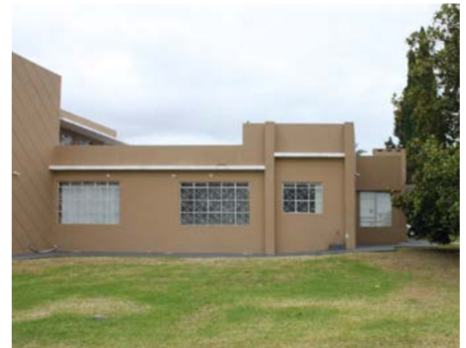
Figura 127: Fotografía rectificada de la fachada lateral Fuente: Autores, 2017
