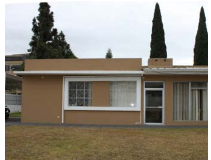
Figura 128: Fotografía rectificada de la fachada posterior Fuente: Autores, 2017
