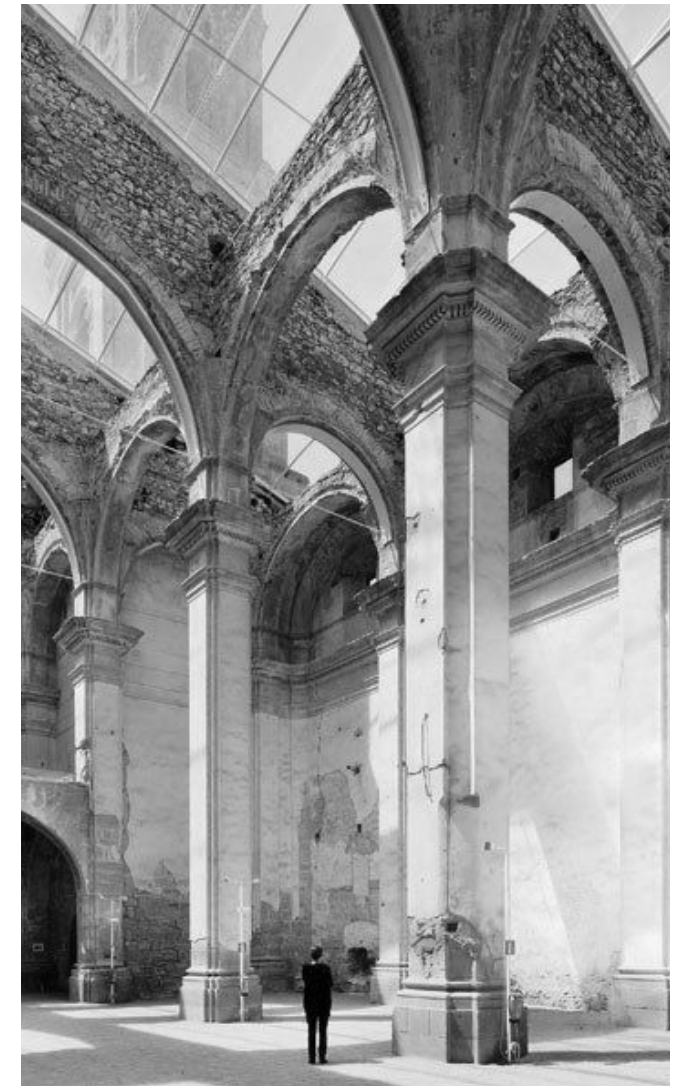
Figura 25: Restauración de una iglesia barroca en Corbera d'Ebre, España por el estudio Ferran Vizoso Architecture.
