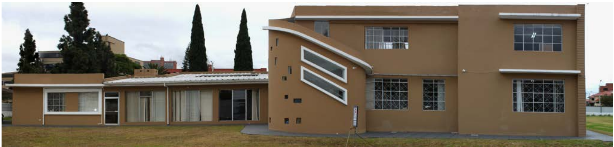
Figura 134: Fachada posterior rectificada. Fuente: Autores, 2017
