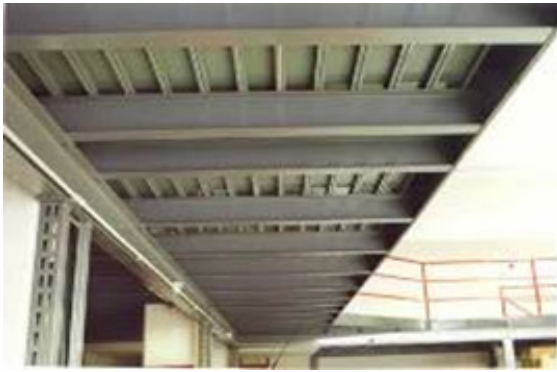
Figura 251: Correas metálicas en losas de hormigón.
