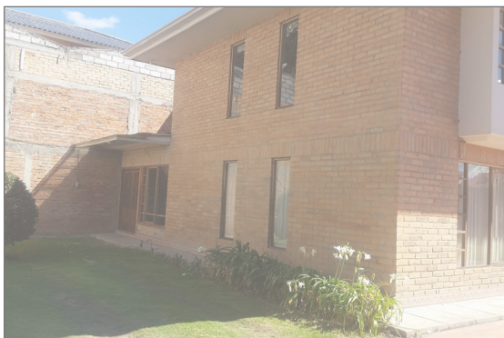
Figura 130: Fotografía II de Vivienda 4. Fuente: Autores de Tesis.
