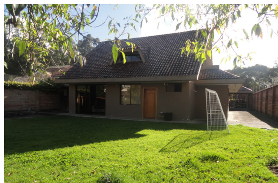
Figura 81: Fotografía III de Vivienda 2. Fuente: Autores de Tesis.
