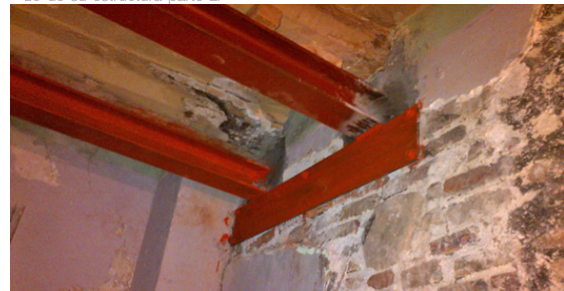
Figura 244: Anclaje a viga empotrada, placa metálica.
