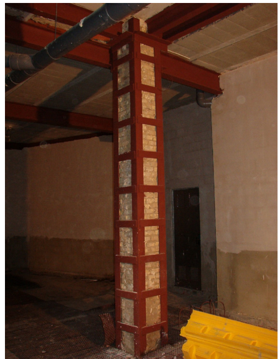
Figura 238: Aplicación del empresillado a una columnas de hormigón aislada.
