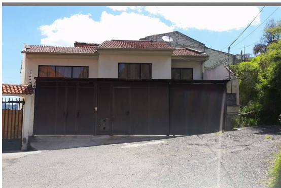
Figura 55: Fotografía II de Vivienda 1.
