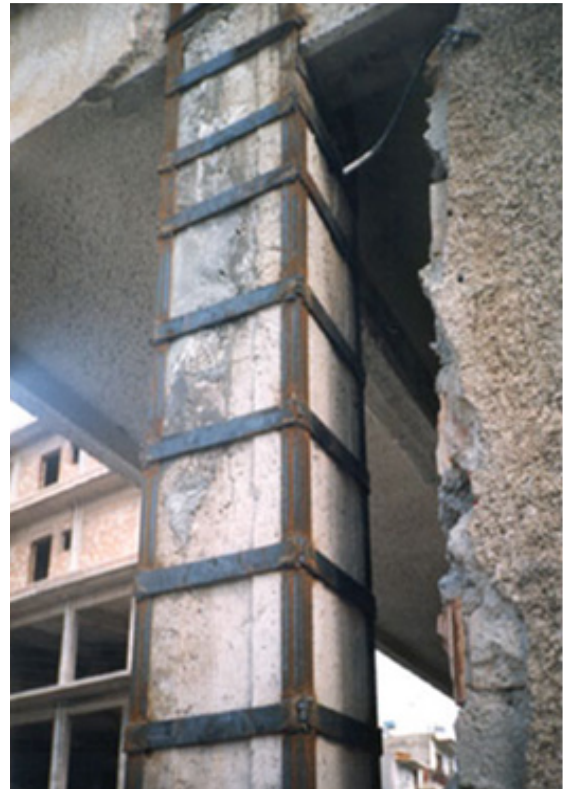
Figura 237: Aplicación del empresillado_ejemplo.
