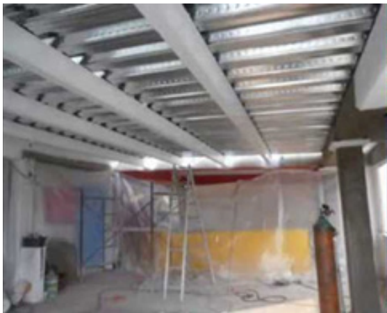
Figura 252: Correas metálicas para grandes luces
