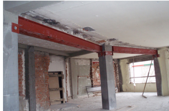
Figura 242: Refuerzo de vigas de hormigón con perfiles metálicos tipo I.
