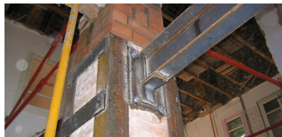
Figura 245: Anclaje a viga empotrada, placa metálica
