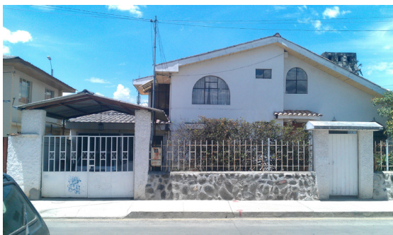
Figura 105: Fotografía II de Vivienda 3. Fuente: Autores de Tesis.
