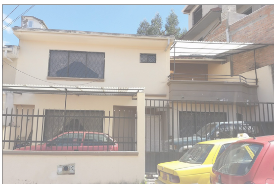
Figura 180: Fotografía II de Vivienda 6. Fuente: Autores de Tesis.
