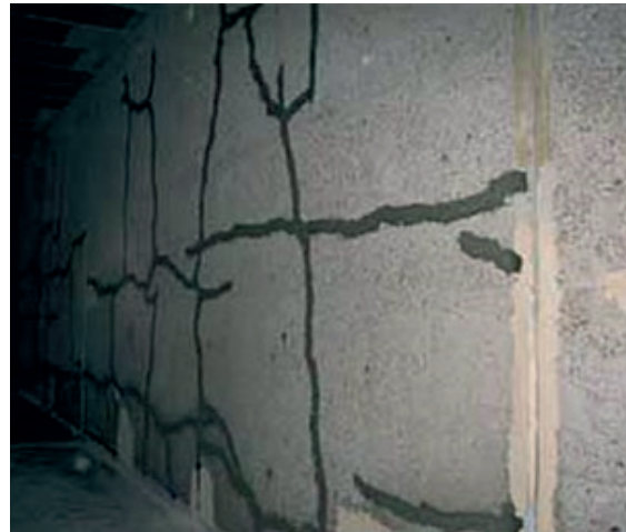
Figura 254: Sellado de grietas mínimas en muros
