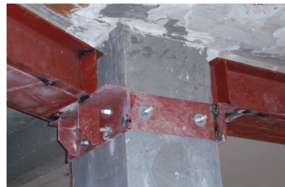
Figura 243: Anclaje a columnas de refuerzo metálico.
