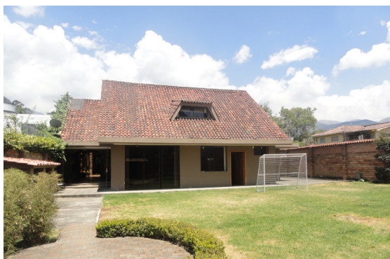
Figura 80: Fotografía II de Vivienda 2. Fuente: Autores de Tesis.
