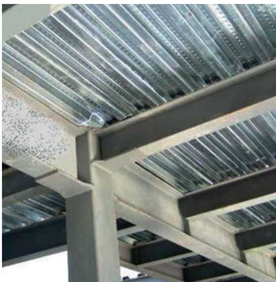
Figura 253: Unión entre vigas principales y correas
