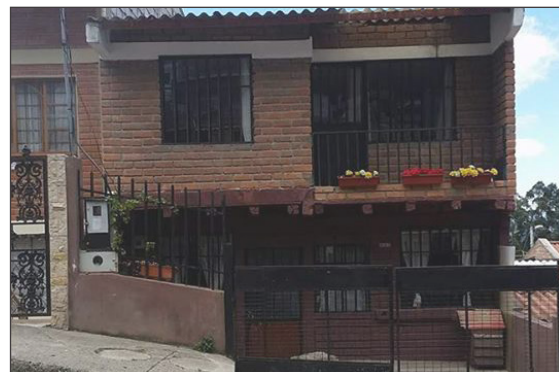
Figura 156: Fotografía III de Vivienda 5. Fuente: Autores de Tesis.
