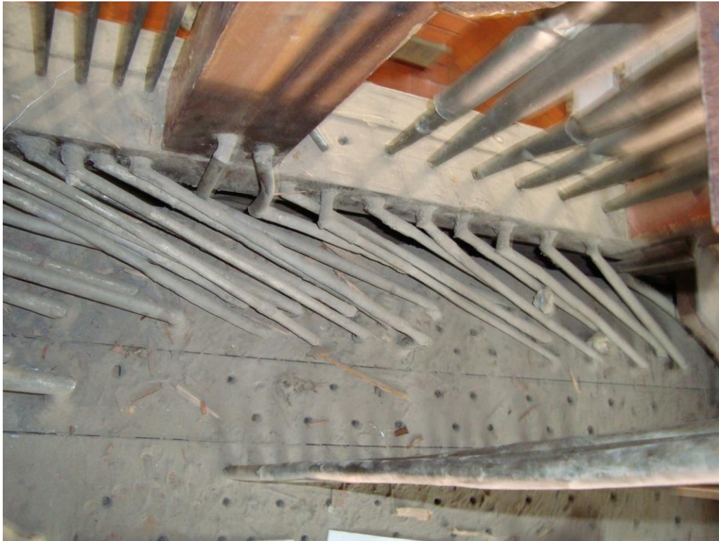
Imagen 2 - Derivación del aire de la secreta a los tubos de fachada, al centro sobre la columna de madera se aprecian dos caños de distribución a las figuras de los infantes (13-05-16)
