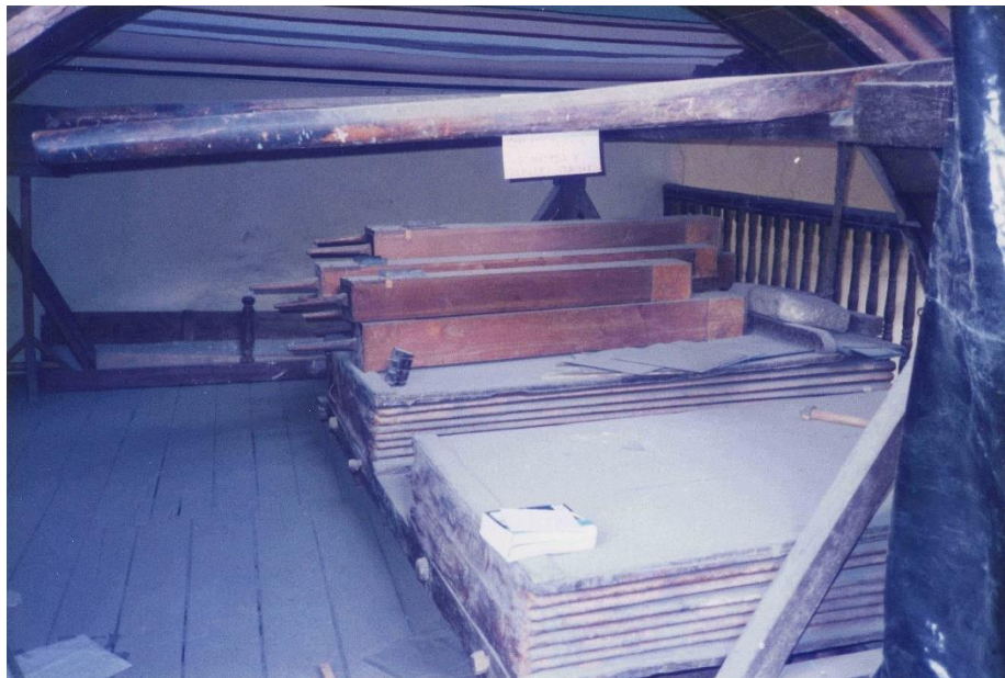
Imagen 4 - (25-01-97) Fuelles de cuña originales, cuatro en total (izquierda)
