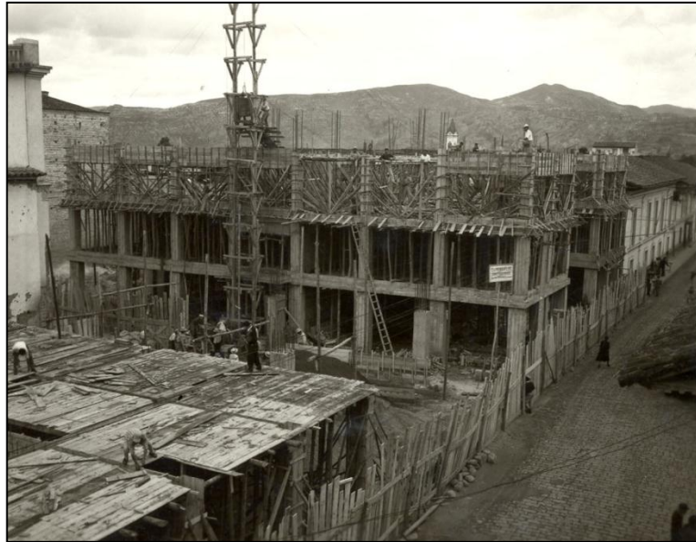
Fotografía 21. Construcción de la Casa de la Cultura, ca. 1950. Fuente: Fototeca DAHP
