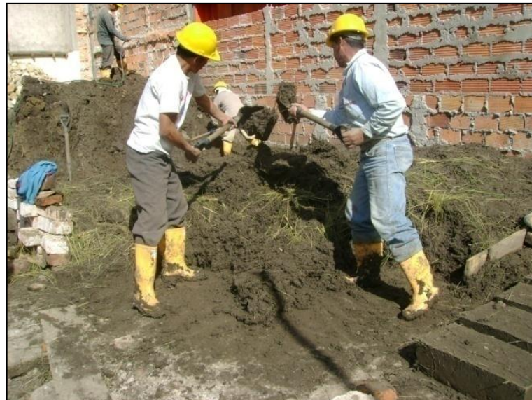
Fotografía 35. Elaboración de adobes, restauración de la Ex Escuela Central, 2009 Fuente: Autora
