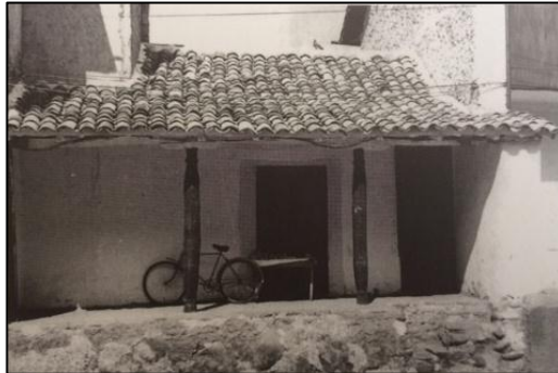
Fotografía 13. Vivienda colonial, 1977 Fuente: Arquitectura Popular de Azuay y Cañar, 1977-1978.
