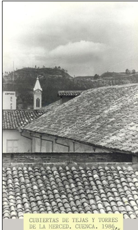
Fotografía 43. Cubiertas de edificaciones de Centro Histórico, 1986. Fuente: Fototeca DAHP
