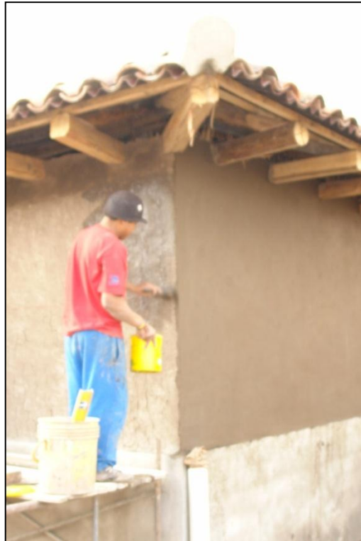
Fotografía 45. Colocación de empañeteo en muro de adobe, Casa Lupercio, 2016 Fuente: Arq. Gustavo Lloret.
