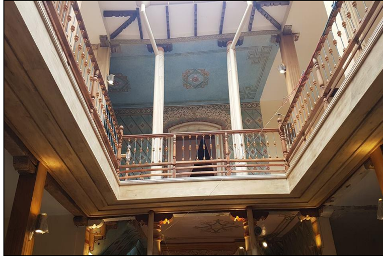
Fotografía No. 47 Centro Múltiple Municipal, obra en ejecución Fuente: Archivo de la DAHP
