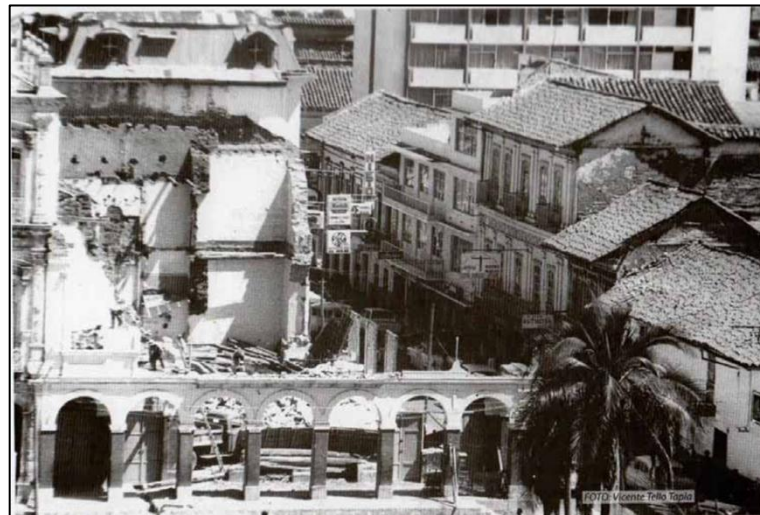
Fotografía 20. Demolición del edificio de la Gobernación. Fuente: Fototeca DAHP
