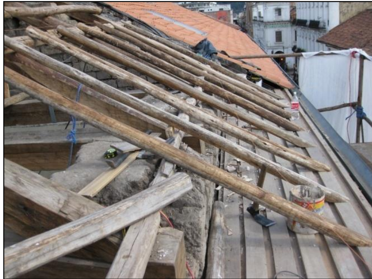
Fotografía 41. Estructura de madera, cubierta edificación patrimonial, 2009 Fuente: Autora
