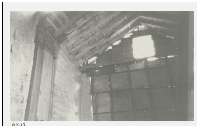
Fotografía 42. Estructura de madera de la cubierta, Iglesia de las Concepcionas, c.a.1970 Fuente: Fototeca DAHP
