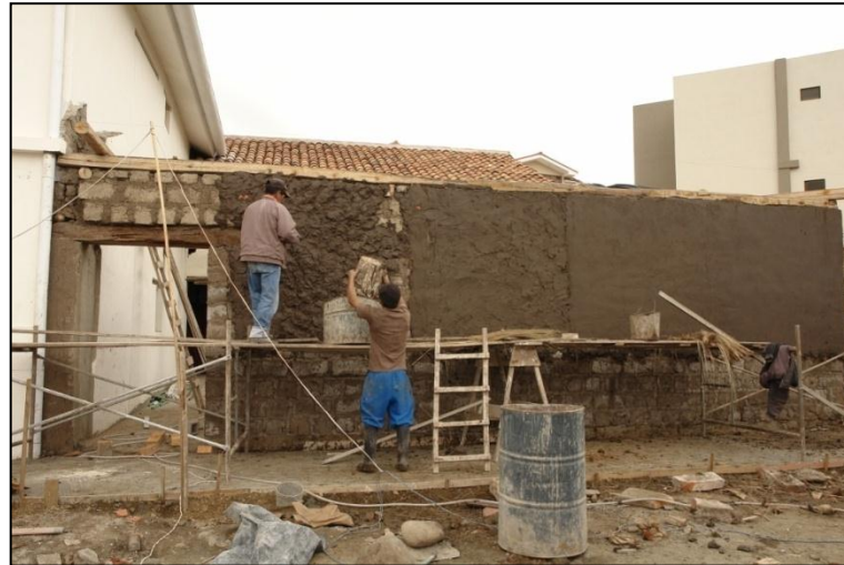
Fotografía 44. Colocación de revoque en muro de adobe, Casa Lupercio, 2016 Fuente: Arq. Gustavo Lloret.
