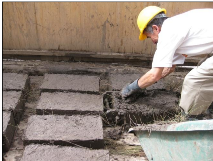
Fotografía 36. Elaboración de adobes, restauración de la Ex Escuela Central, 2009 Fuente: Autora
