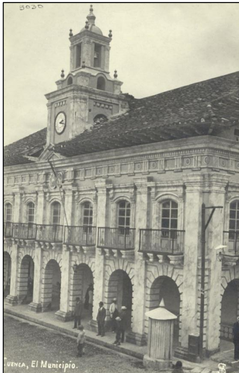
Fotografía 18. Palacio Municipal Fachada calle Mariscal Sucre Fuente: Fototeca DAHP
