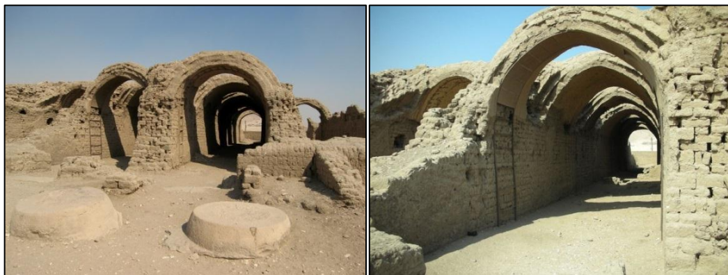
Fotografía 5 - 6. Bóvedas del templo mortuorio de Ramsés II en Gourná, Egipto . Fuente:web. Fecha de ingreso 21/05/2015.
