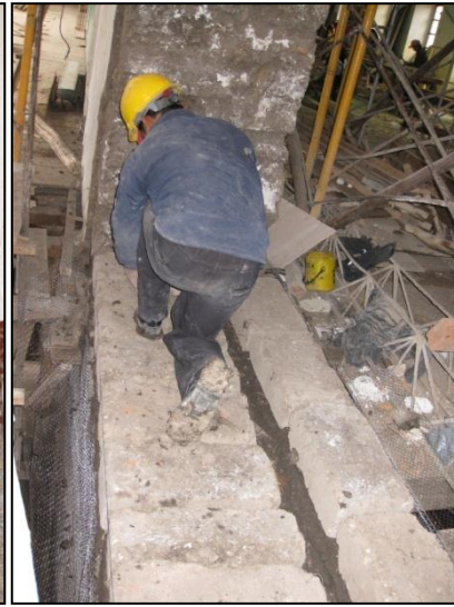
Fotografía 40. Construcción muro de adobe Restauración de la Ex Escuela Central Fuente: Autora
