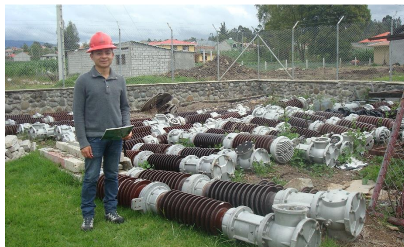
F6: Verificación de equipos disyuntores dados de baja. Visita técnica a la Bodega “Ricaurte”, CENTROSUR. Fuente: Autor, 2017.
