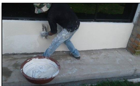
Ilustración 11. Aplicación en campo de las formulaciones Ex-19 y Ex-20
