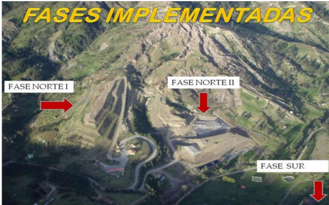
Figura 3.1 Relleno Sanitario Pichacay Fuente: EMAC-BGP ENERGY CEM
