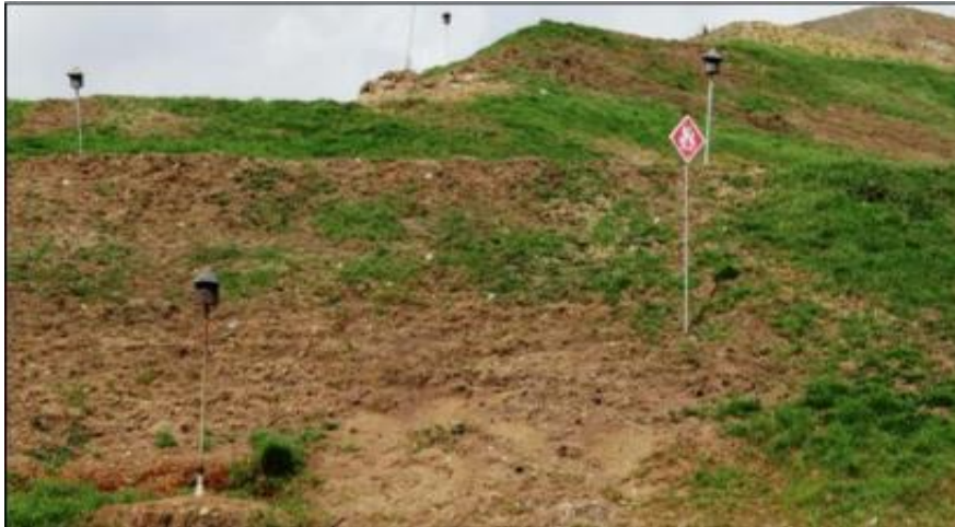
Figura 3.2 Pozos de oxígeno en el relleno Pichacay Fuente: http://.emac.gob.ec/?q=node/420
