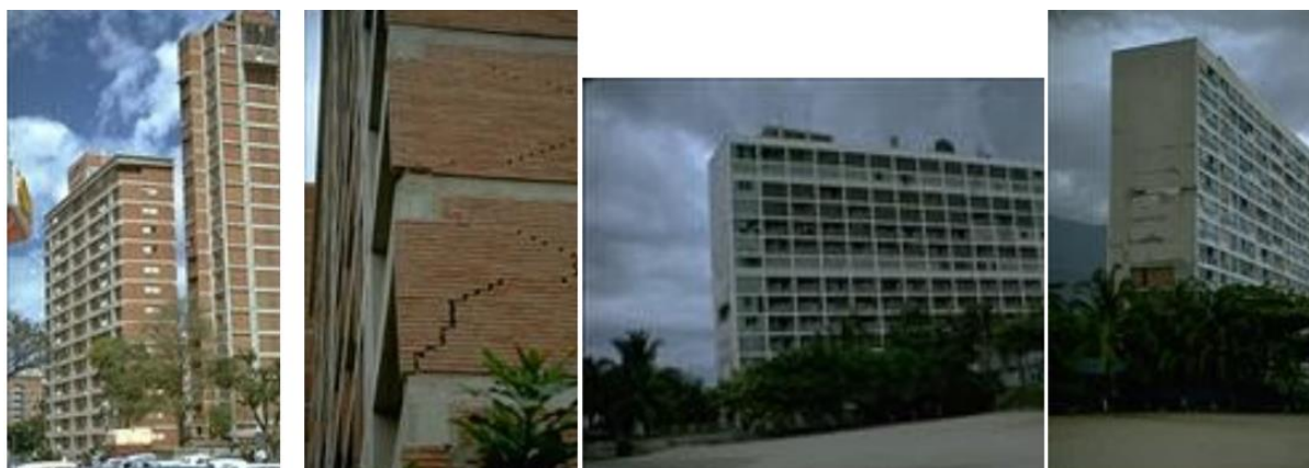
Figura 24. Edificios poco redundantes que presentaron daño estructural durante el sismo de Caracas. (Karl Steinbrugge, Web-Berkeley. 2010)
