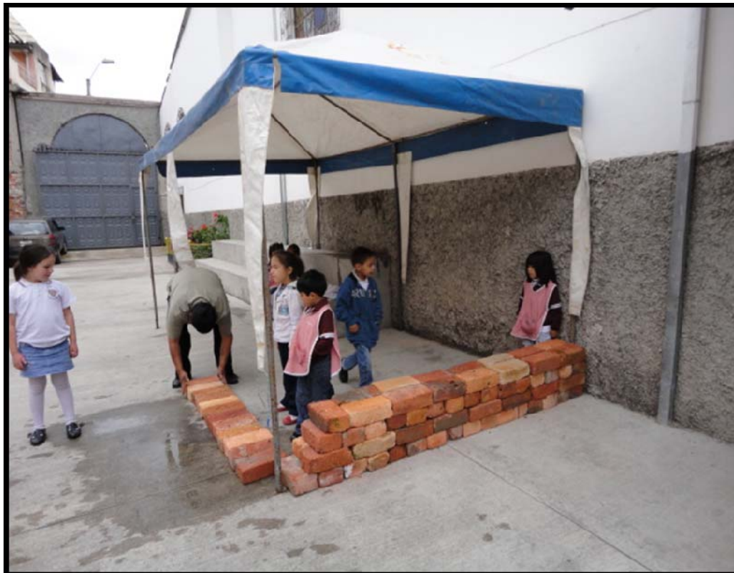
Construcción del lugar estratégico para el Patio Pedagógico
