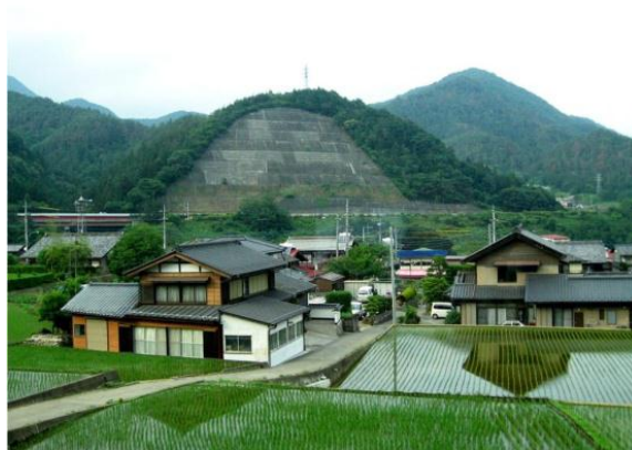
Fotografía 88: Muros de sostenimiento
