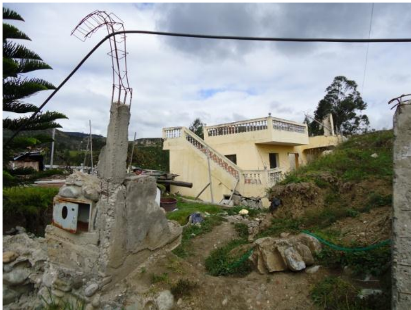
Fotografía 44: Viviendas afectadas por deslizamiento en San Miguel (Challuabamba)
