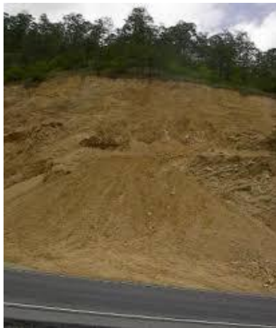
Fotografía 86: Desmonte de Tierras
