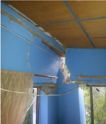
Fotografía 50: Fisuras de las paredes y pisos sector Centro Parroquial
