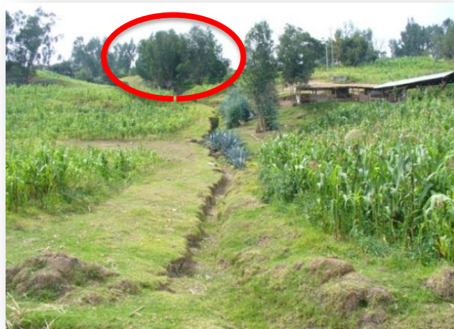
Fotografía 37: Zanjas de drenaje en el deslizamiento Sector Santa Cecilia – Ventanillas año 2010
