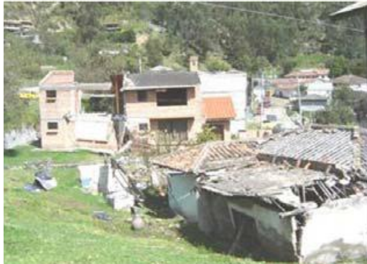
Fotografía 48: Vivienda destruida en el centro parroquial
