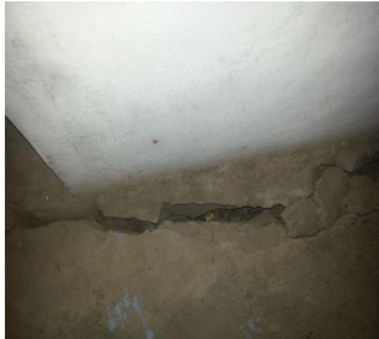
Fotografía 50: Fisuras de las paredes y pisos sector Centro Parroquial
