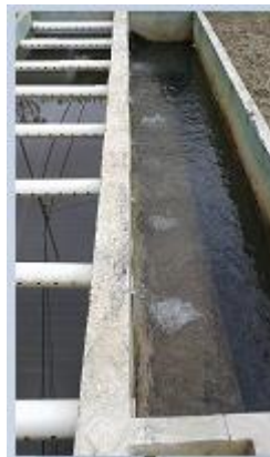
Figura 17: Proceso de Sedimentación
